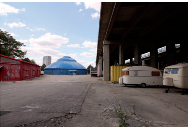
Occupation actuelle du site vue vers les locaux occupés par Espace Périphérique. À noter : contrainte de la poutre et des piles du boulevard périphérique.
