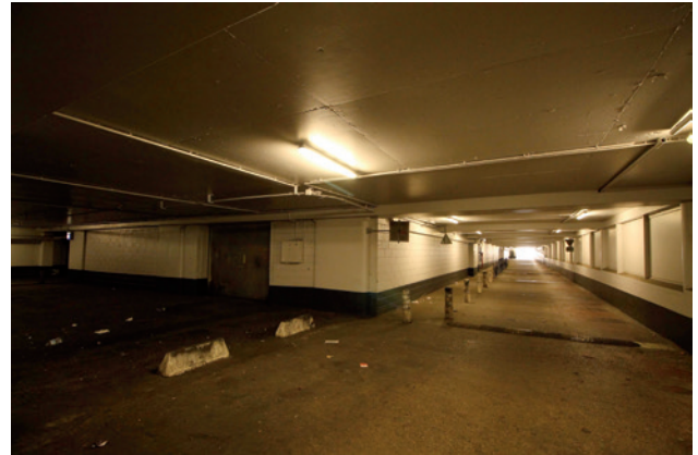
4 - Tunnel d'accès depuis le BP extérieur
