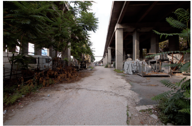
Occupation actuelle du site vue depuis la rampe d'accès PL. Environ 6 m de largeur libre entre les piles de soutien du BP.
