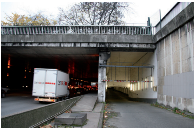
Vues vers l'accès à l'ancienne station Shell depuis le BP extérieur. Espace Champerret qui contraint la hauteur de la rampe d'accès à 2,40 m sous plafond.
