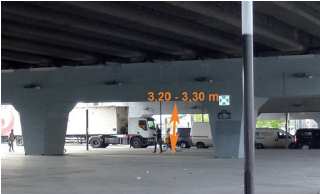
Contrainte de hauteur liée à la poutre entre les piles de soutien du Boulevard périphérique
