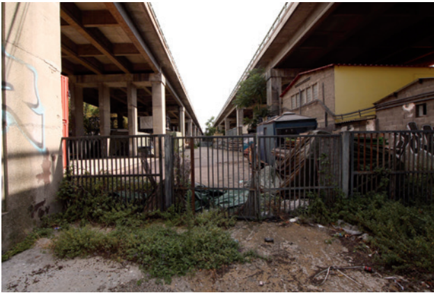
Vue depuis la rue de la Clôture entre les deux tabliers du BP extérieur à gauche et intérieur à droite. Environ 10 m de largeur libre entre les piles de soutien du BP.
