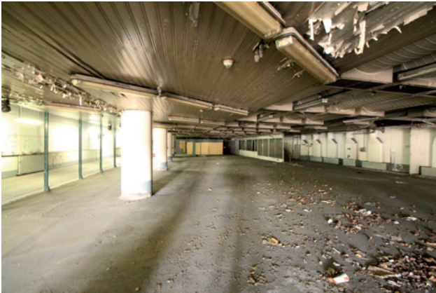
1 - Vue vers l'ancienne station Shell directement accessible depuis le BP intérieur
