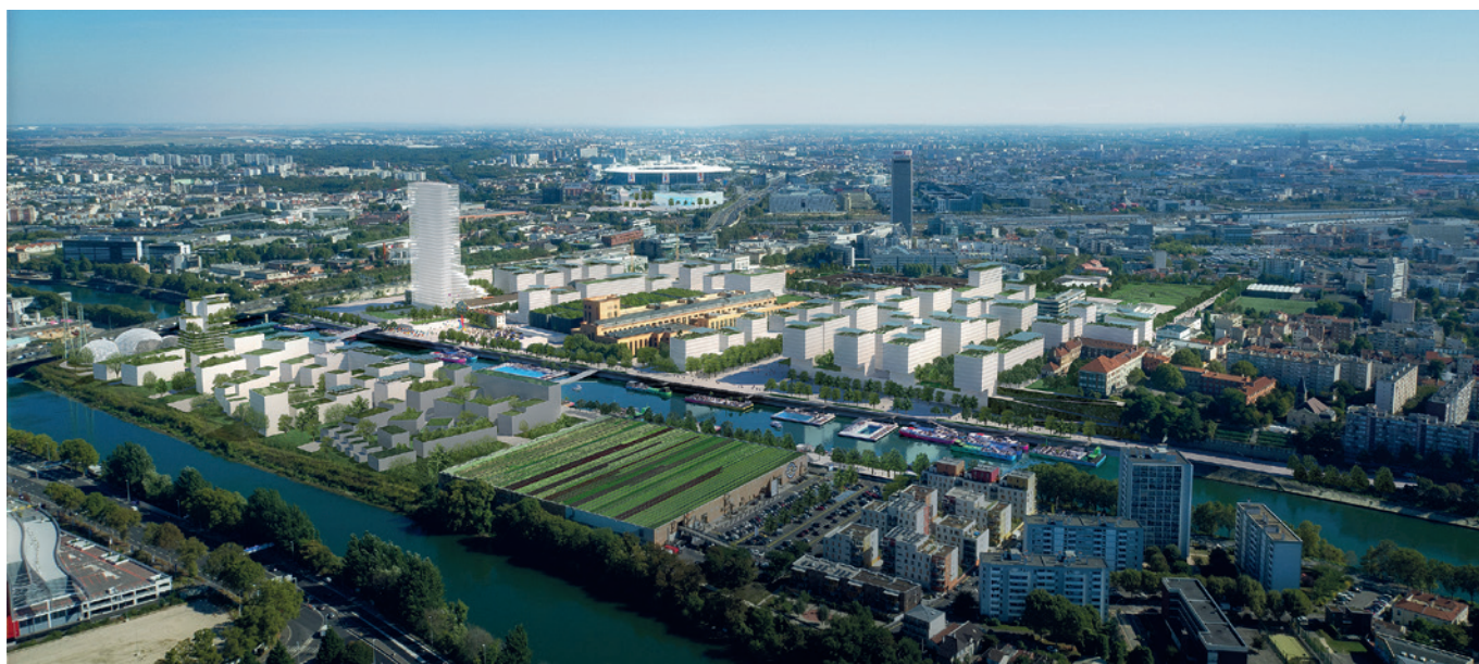
Vue perspective du village olympique et paralympique avec le stade de France en second plan et la tour Pleyel et le futur hub métro
