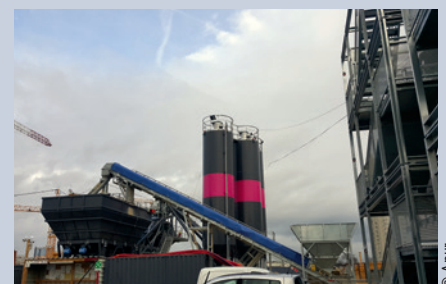
Centrale à béton sur le chantier du projet Chapelle International
