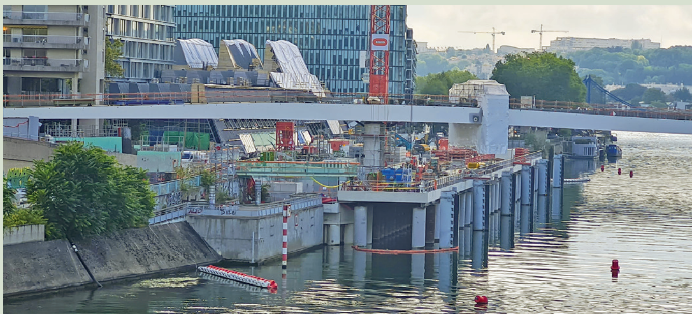
Estacade pour évacuer par la Seine les déchets sur le chantier de la gare de Pont de Sèvres
