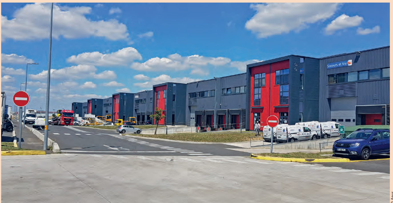
La zone Cargo de Paris-Orly réhabilitée en 2017
