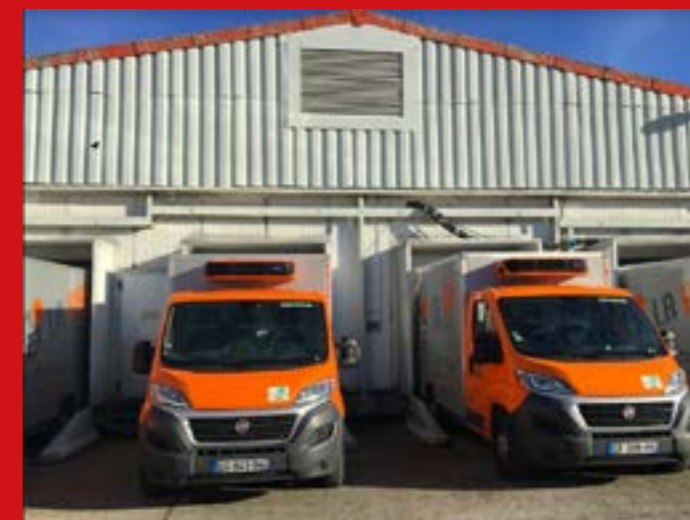
Portes à quais des Boucheries d'Ile de France à Romainville
