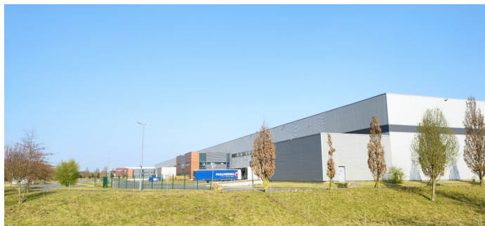
Entrepôts logistiques de matériaux en Seine-et-Marne ©MRAe IdF.
