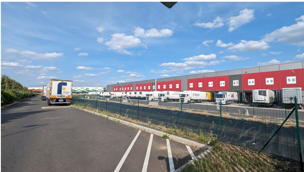
Entrepôts pour de l'alimentaire en Essonne (91), les dispositifs de réfrigération émettent d'importantes nuisances sonores ©MRAe IdF.
