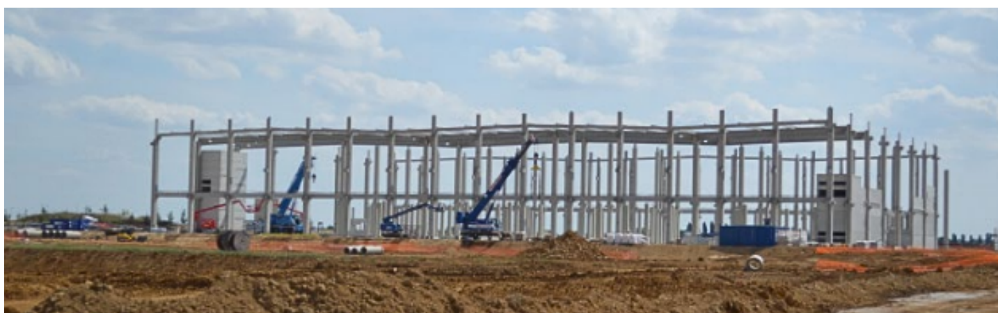
Construction d'un entrepôt pour un des géants de l'e-commerce sur le site de Villaroche (77) ©MRAe.
