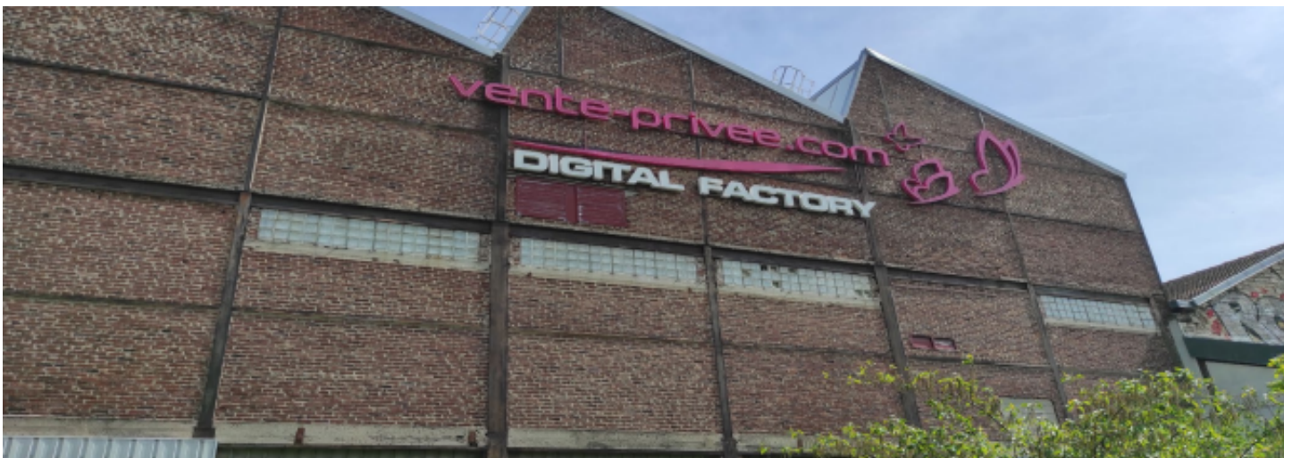
Entrepôt urbain d'un des leaders du commerce électronique à Saint-Denis (93) ©MRAe IdF.
