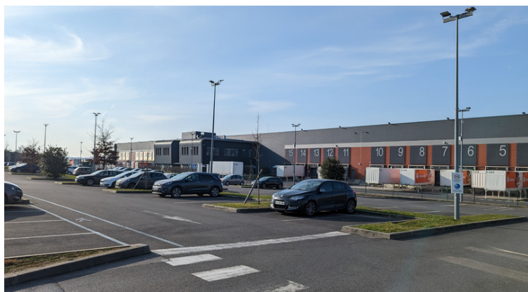
La construction des bâtiments logistiques s'accompagne d'une forte imperméabilisation sur l'emprise des projets. ©MRAe IdF.
