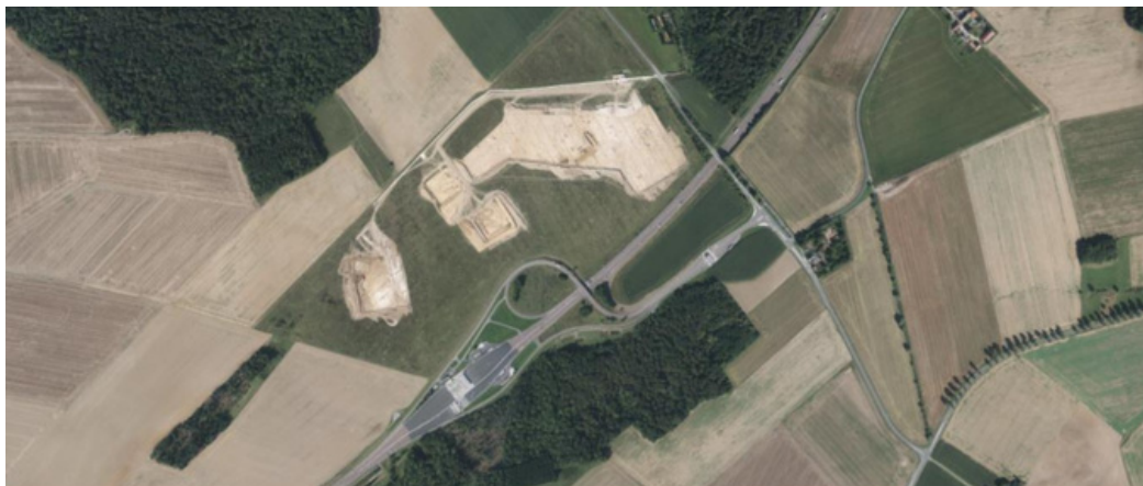
Plateforme logistique en cours de réalisation à Dhuisy (77) le long de l'autoroute A5. La MRAE s'interroge sur les facultés pour les employés de venir par d'autres moyens de transport que la voiture individuelle lorsque les entrepôts sont isolés ©MRAE.
