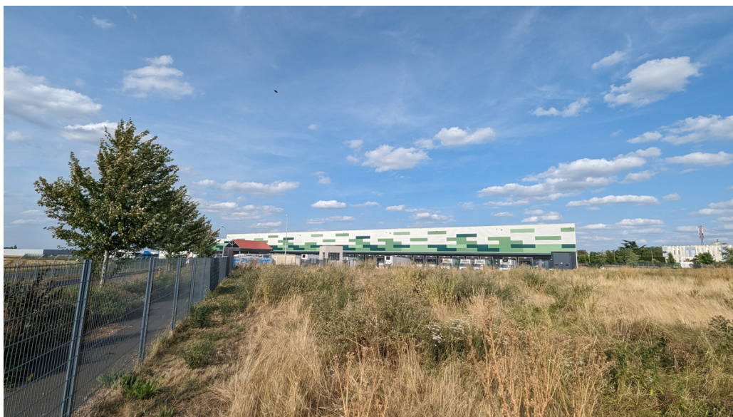
Entrepôt en bout de piste de l'aéroport d'Orly (94) ©MRAe.
