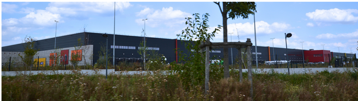
Entrepôts logistiques dans le secteur de Servon (77) ©MRAe
