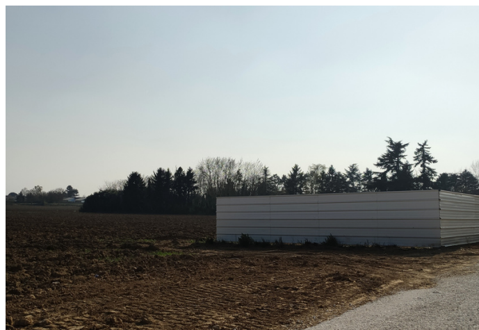
Démarrage d'un chantier de construction d'un bâtiment logistique à Brie-Comte-Robert (77) ©MRAe IdF.
