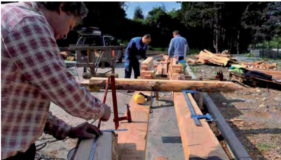
Construction de l'abri à vélo
