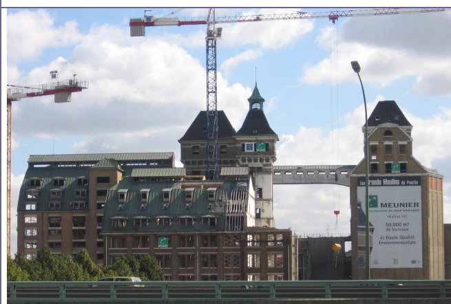
Les Grands Moulins de Pantin (50 000 m 2 ) accueilleront en 2009 les équipes de la BNP spécialisées dans les échanges boursiers
