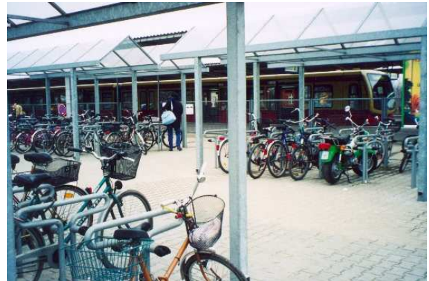
Parc de stationnement vélo de 300 places sur un quai de station S-Bahn Photo I AURIF
