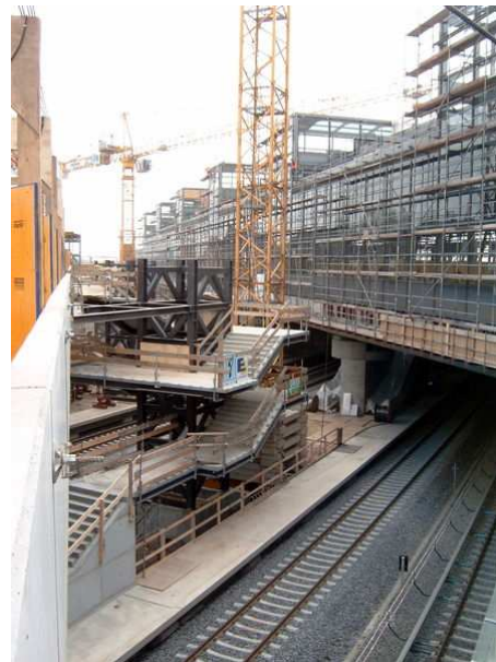
Südkreuz : Etat des travaux en 2005 Document S-Bahn-Berlin GmbH
