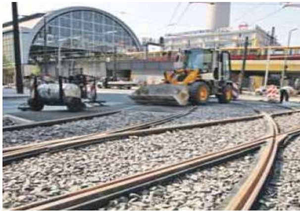
Travaux de mise en site propre d'une ligne de tramway
