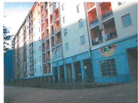
Rénovation du quartier de Sant Eusebio.
