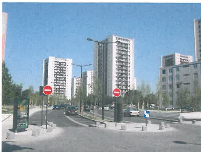
Ouverture de voies et création de ronds-points dans un grand ensemble ©laurif
