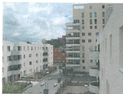
Opération de résidentialisation - © laurif
