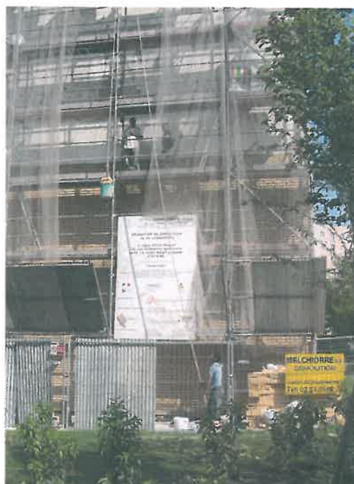
Opération de rénovation urbaine ©laurif
