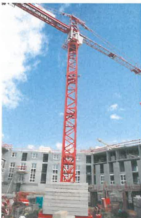
Construction de logements ©laurif
