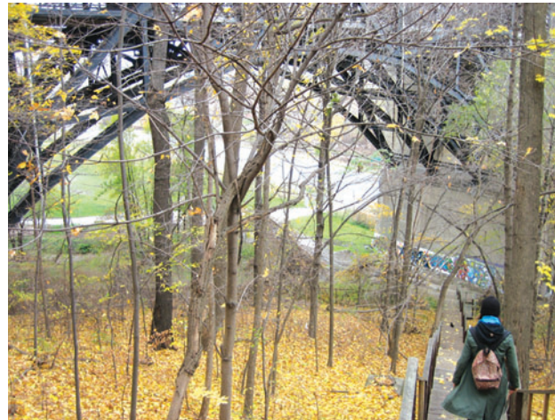
Ouvrage d'art s'étendant au dessus et dans le ravin
