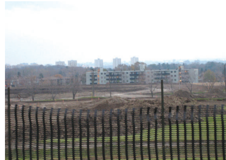
Travaux sur le site de Downsview Park
