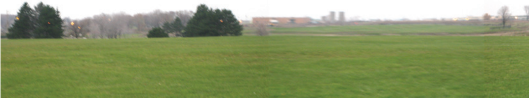
Downsview Park avant les travaux
