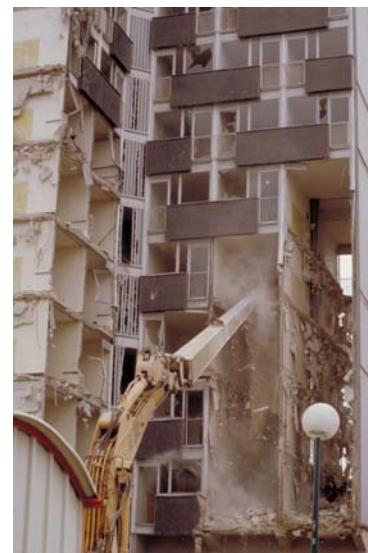
Démolition à Massy, Ile-de-France © laurif
