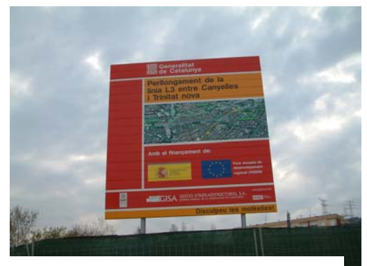
Prolongement d'une ligne de métro dans le quartier de Trinitat Nova à Barcelone © laurif
