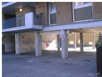
Immeuble dégradé, Londres © laurif
