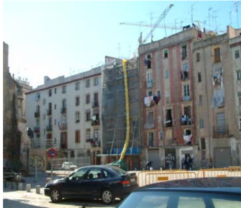
Constructions de logements et rénovation à Ciutat Vella, Barcelone © laurif
