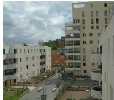
Opération de résidentialisation, Ile-de-France © laurif
