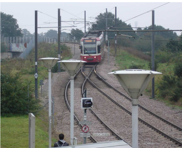
Arrivée sur double voie désaffectée
