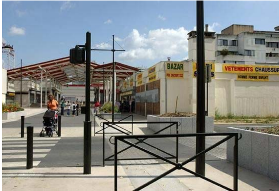
Rénovation de l'entrée du centre commercial La Verrière
