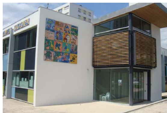
Le nouveau bâtiment de la Maison des services pour tous
