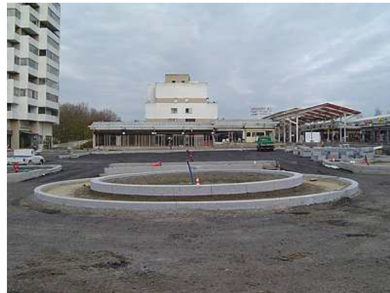
Travaux d'aménagement des entrées du centre commercial la Verrière, novembre 2006
