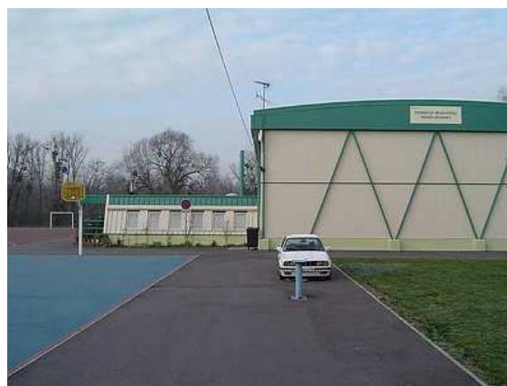
Rénovation du gymnase du collège Henri Dunant Janvier 2007.
