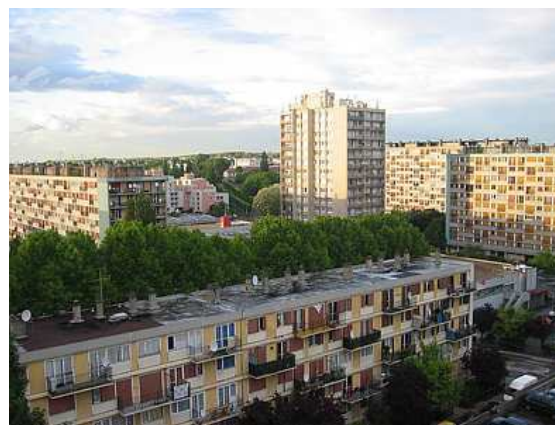
Vue de Clichy avant travaux
