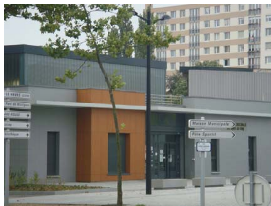
Maison municipale du Bois au Coq, Mare Rouge
