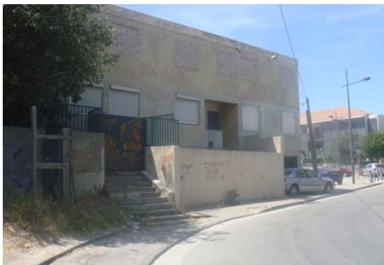
Bâtiment de l'école à démolir
