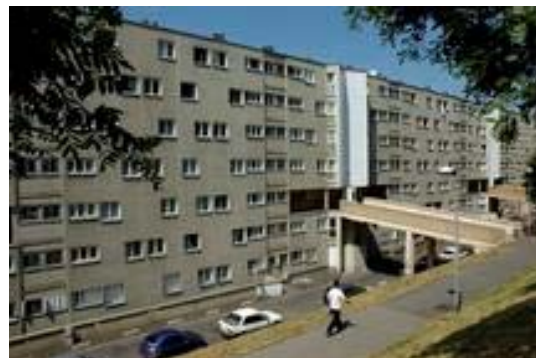
Vue de la barre avant travaux
