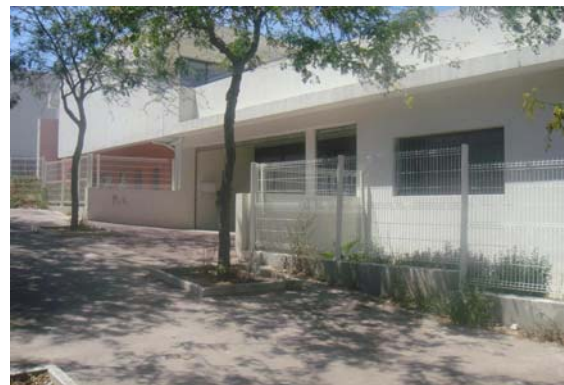
Le centre social côté rue
