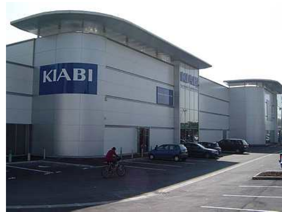
Meaux, Quartier Beauval - Installation de nouveaux commerces Avenue des comtes de Champagne, octobre 2006
