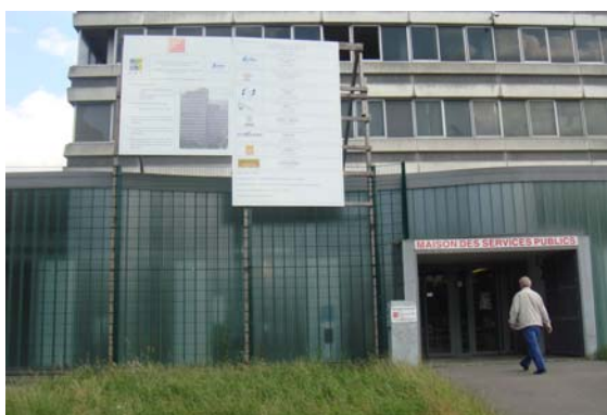
La maison des services publics au pied de la tour Utrillo
