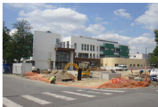
Construction de la résidence personnes âgées
