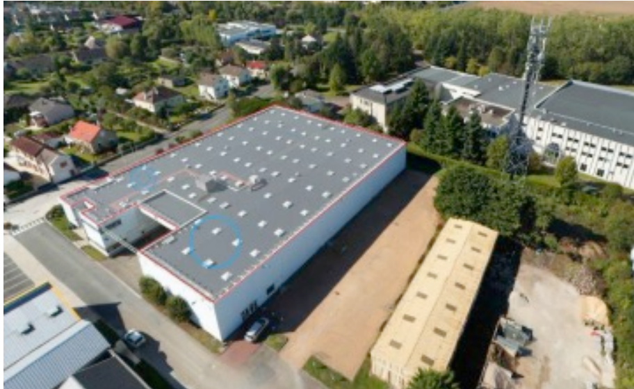
Espace municipal de 9 bâtiments dont CTM, Médiathèque, associations, salle des fêtes, ...
