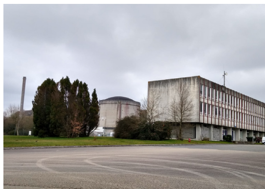
Centrale nucléaire de Brennilis, chantier pilote de démantèlement, mars 2021.
