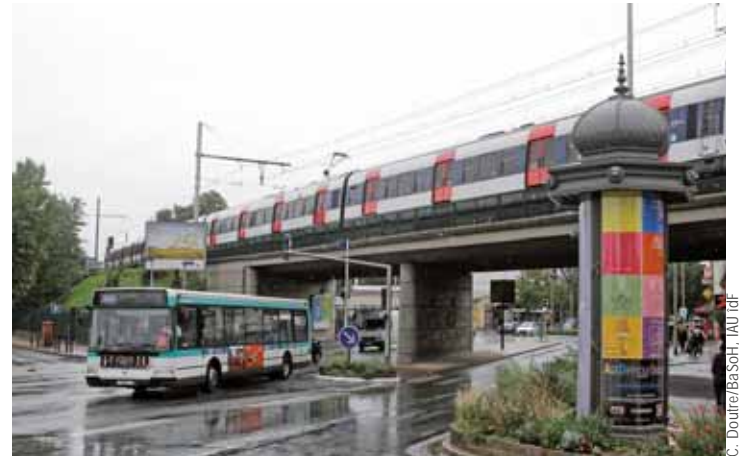
RER A et bus RATP à Saint-Maur-des-Fossés (94)
