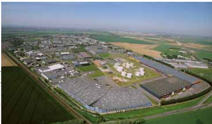
Depôts d'hydrocarbures CCMP sur la zone industrielle de Mitry-Compans
