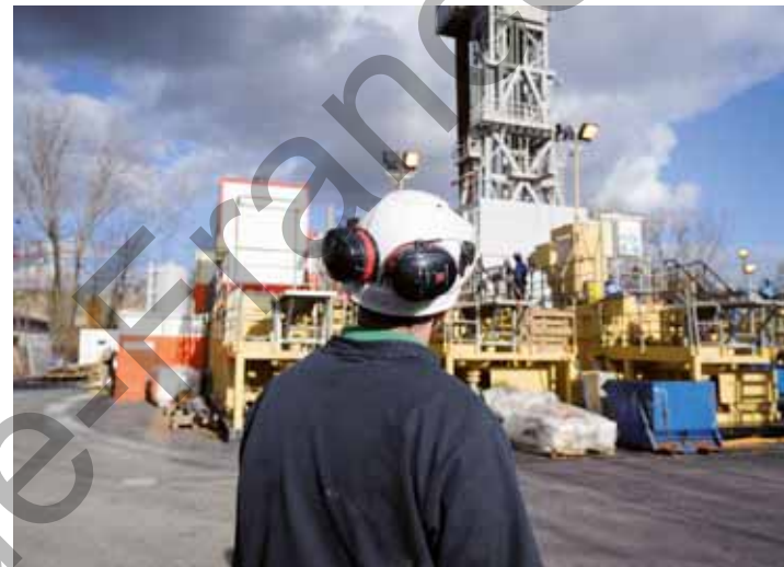
Chantier de forage géothermique à Gentilly (94)
