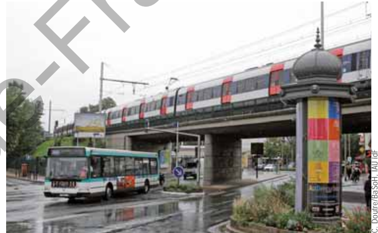
RER A et bus RATP à Saint-Maur-des-Fossés (94)
