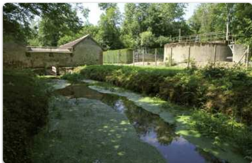
Station d'épuration et lavoir à Bazoches- les-Bray (77).
