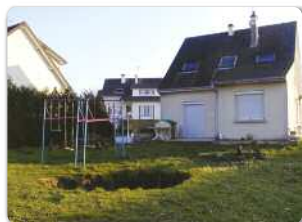
Après des affaissements de terrains, des vides peuvent remonter vers la surface et provoquer une cavité appelée « fontis ». IGC/Versailles
