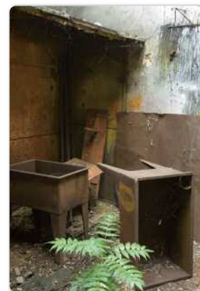
Sol pollué dans un ancien atelier de métallurgie à Arcueil (92).
