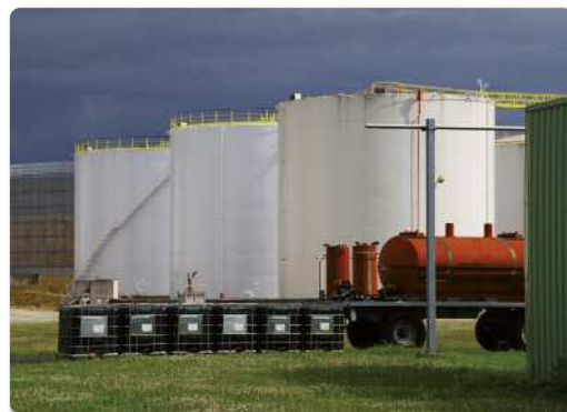
Site Seveso de stockage pétrolier à Coignières (78). B. Raoux/IAU IdF
