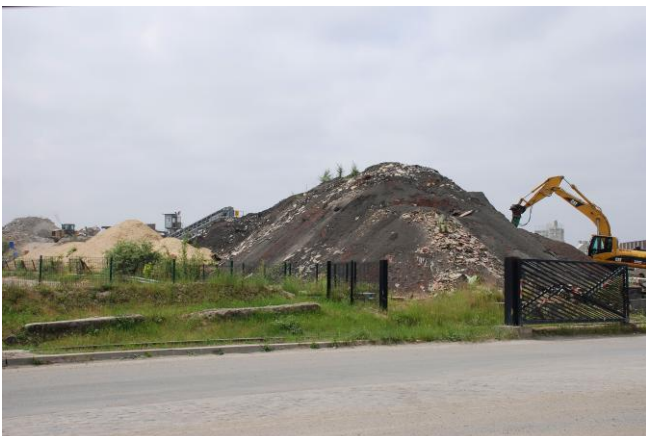
Aire de stockage de matériaux de démolition à Gennevilliers (92).
