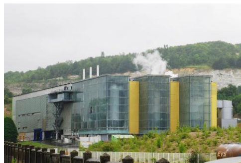
Centre de valorisation énergétique Valène à Mantes-la-Ville (78). Crédit photo : B. Raoux / IAU îdF
