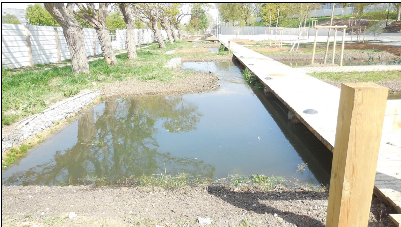
Parc Molière – Ru d’Orgeval – bief du Moulin – Le miroir d’Eau Printemps 2017 – chantier en cours
