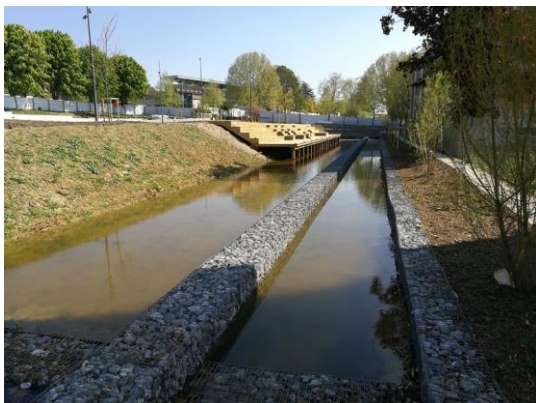
Parc Molière – Ru d'Orgeval bief du Moulin Printemps 2017 – chantier en cours
