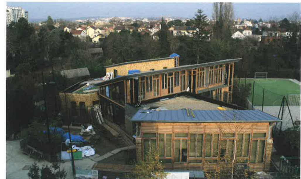
Vue aérienne de la Maison de la Réserve en chantier, derrière on aperçoit la réserve écologique
