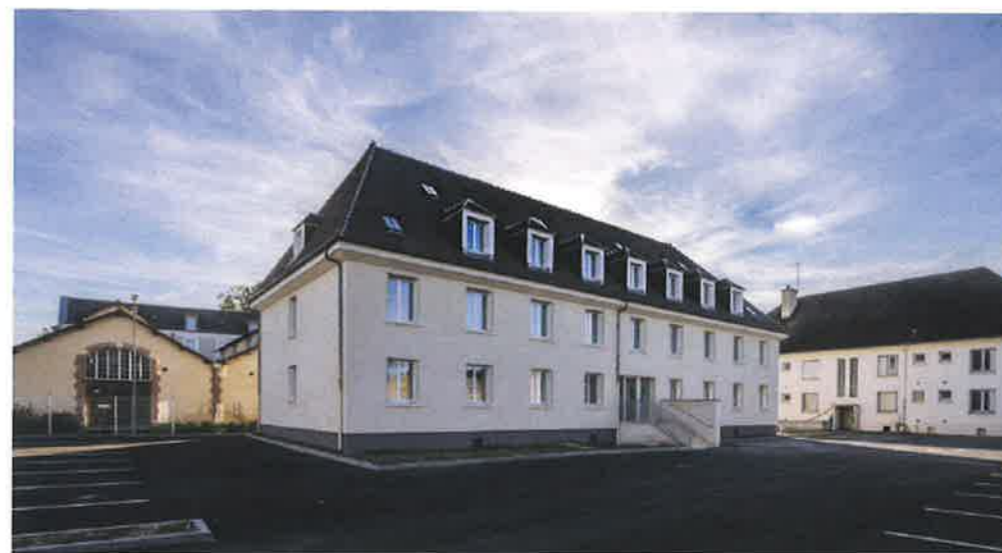
La façade de la Caserne Ordener isolée en paille et enduit plâtre après sa transformation
