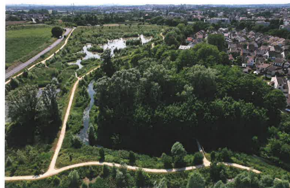
Après le projet, le Croult peut déborder dans la zone d'expansion des crues (à gauche), tandis que le quartier pavillonnaire du Vignois (à droite) est désormais protégé des inondations
