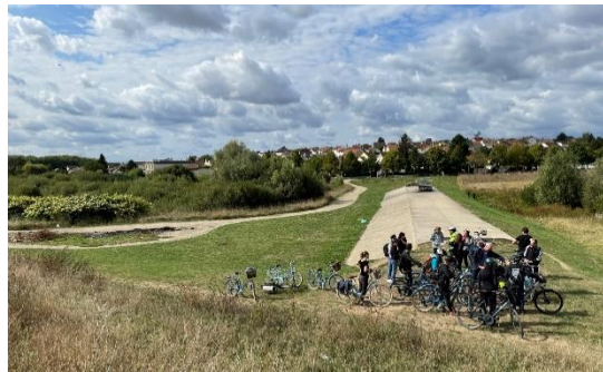
Ouvrage du bassin d'Orville (Louvres)
