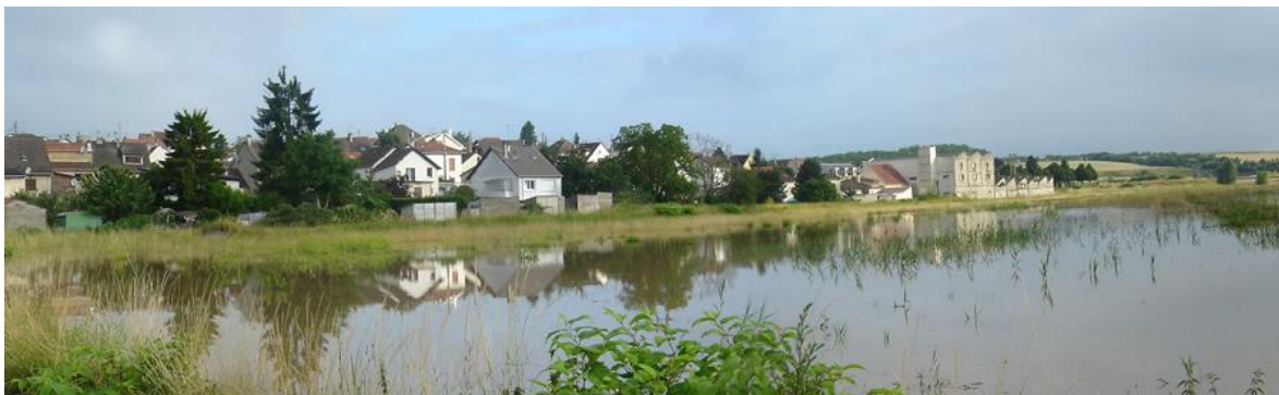
Le Bassin du Bois d'Orville à Louvres rempli après l'orage, protège les quartiers de Goussainville à l'aval. (Source : SIAH)
