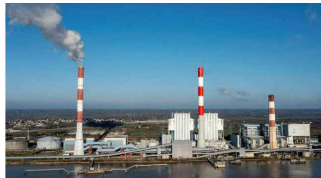
Centrale thermique de Cordemais fonctionnant en appoint/ secours au réseau ~ 1000 h/ an 1,2 GWé (2x 600 MWé) - charbon (+ fioul) Hauteur des cheminées : 220 m
