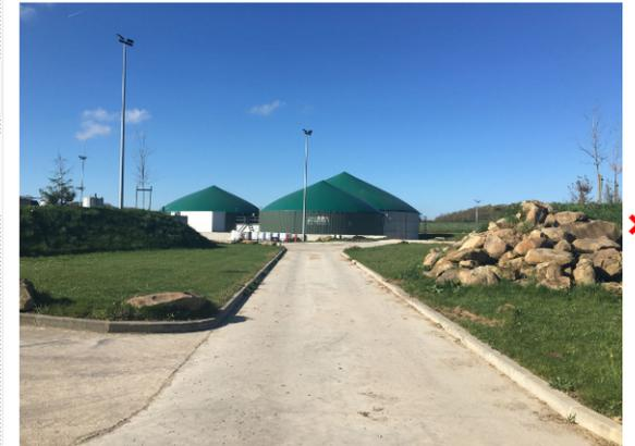
Les trois cuves de l'unité de méthanisation (digesteur, post-digesteur et silo de stockage du digestat), toutes coiffées d'un « toit » conique en bâche souple qui se déplace verticalement selon la quantité de gaz.
