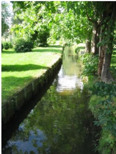
La Mérentaise avant travaux
