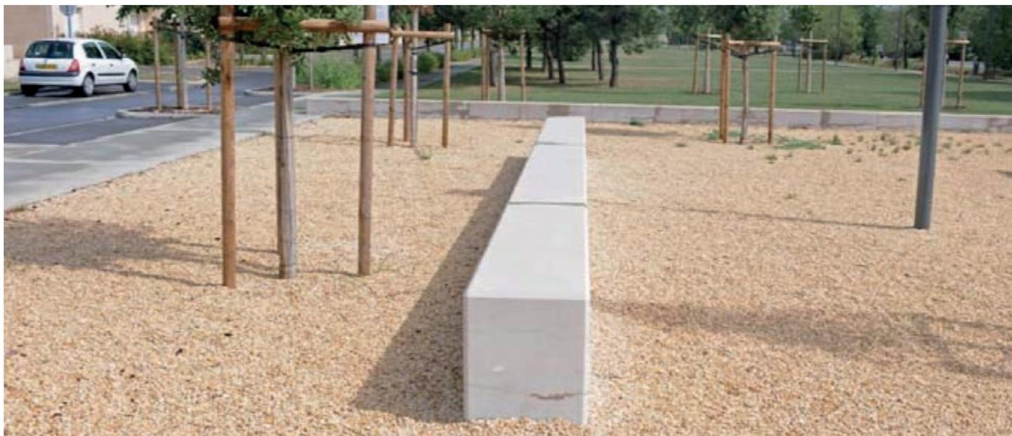
*Exemple d'un sol alvéolaire rempli de stabilisé. Source : Grand Lyon*
