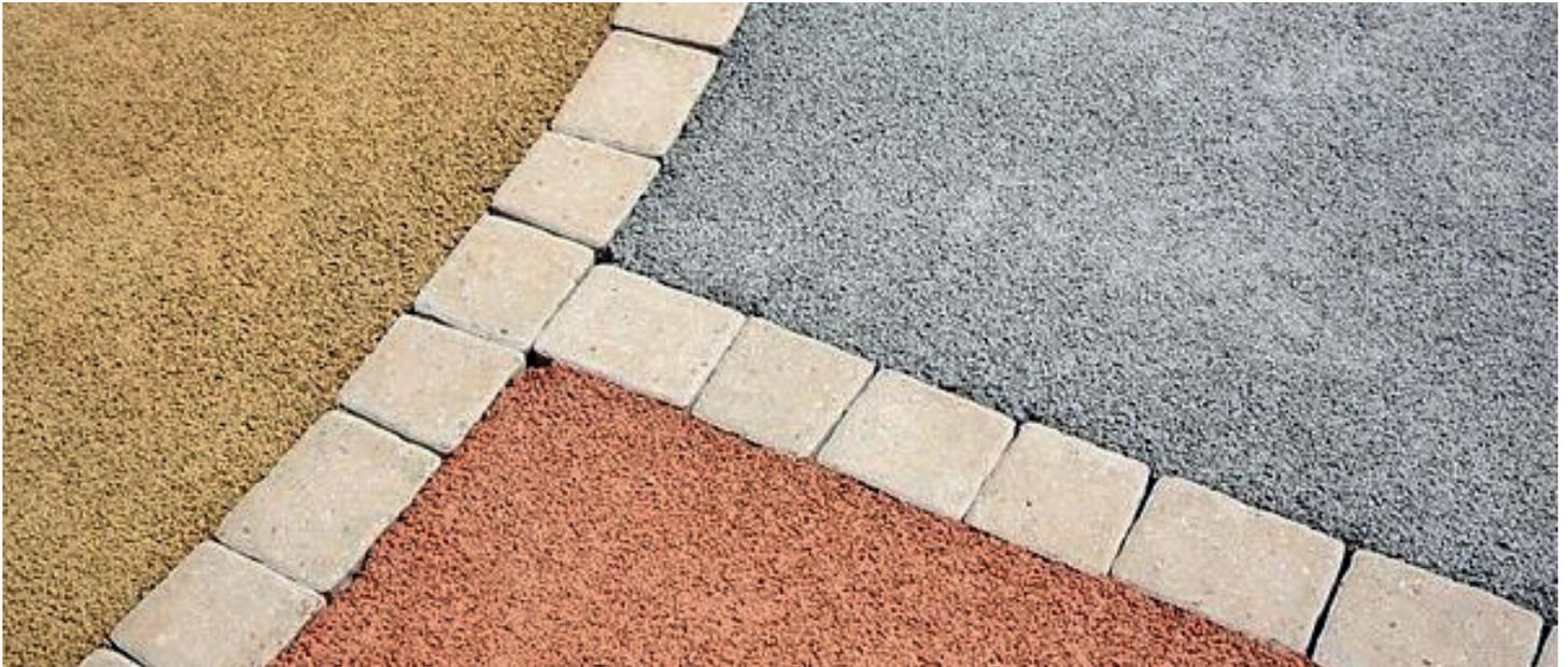
*Exemple de Béton drainant. Source : Teralta*
