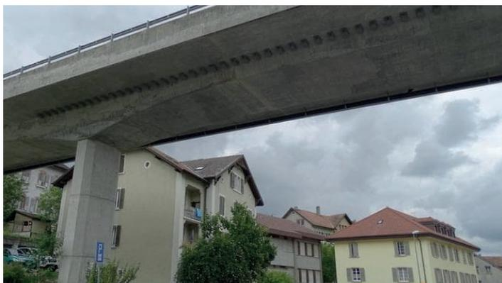
*Photo d'un pont avec nichoirs intégrés.*
