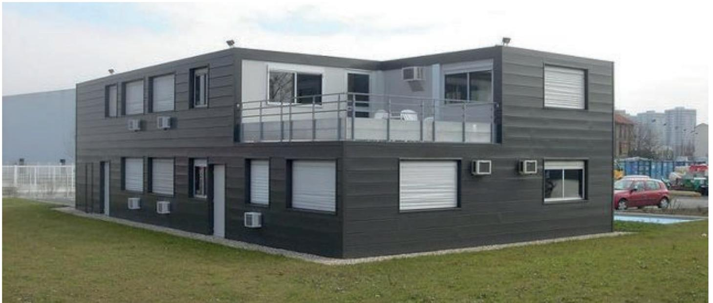
*Exemple d'une construction modulaire. Source : Usine nouvelle*
