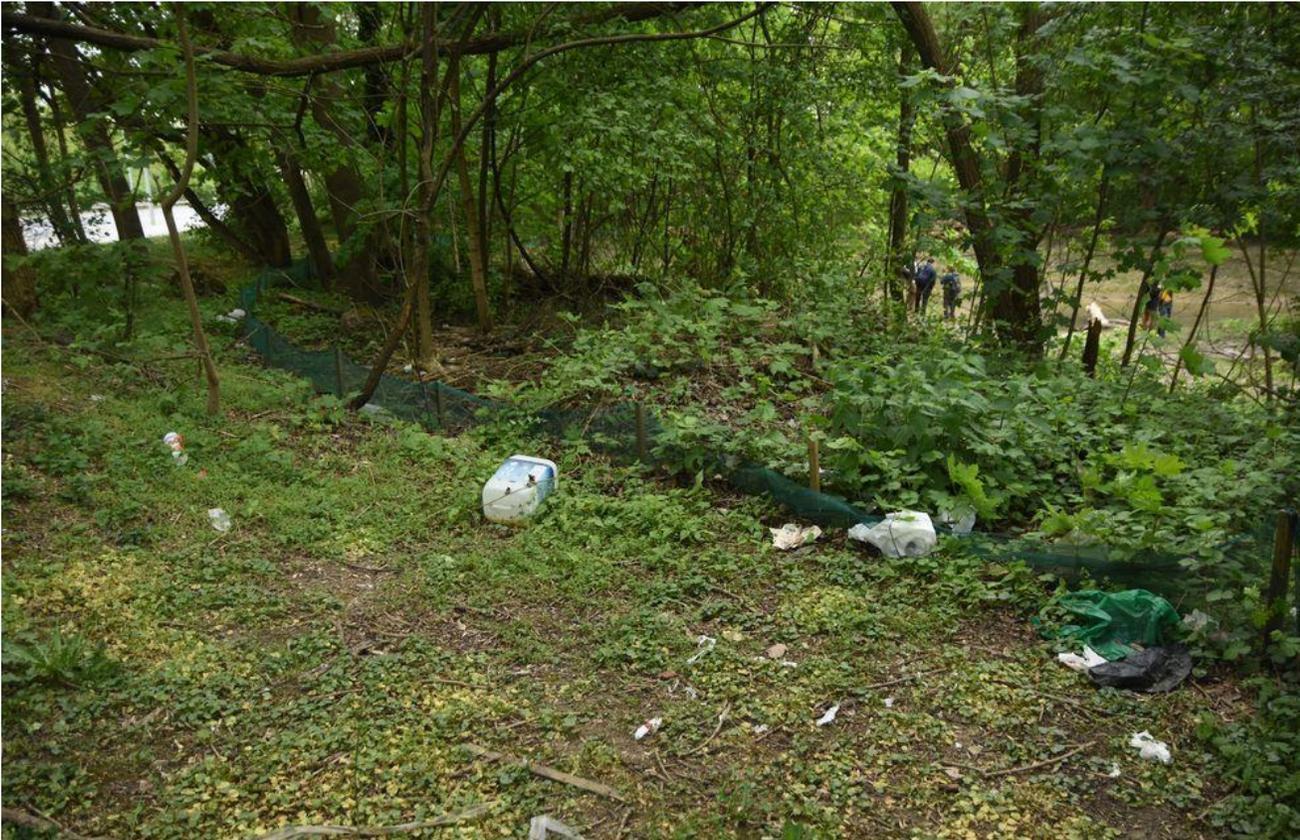
**Mesure de réduction en phase chantier** : pose de barrière anti-retour pour empêcher les amphibiens de regagner l'emprise travaux depuis la mare de transfert. Les barrières ne sont pas fonctionnelles (23/04/19)
