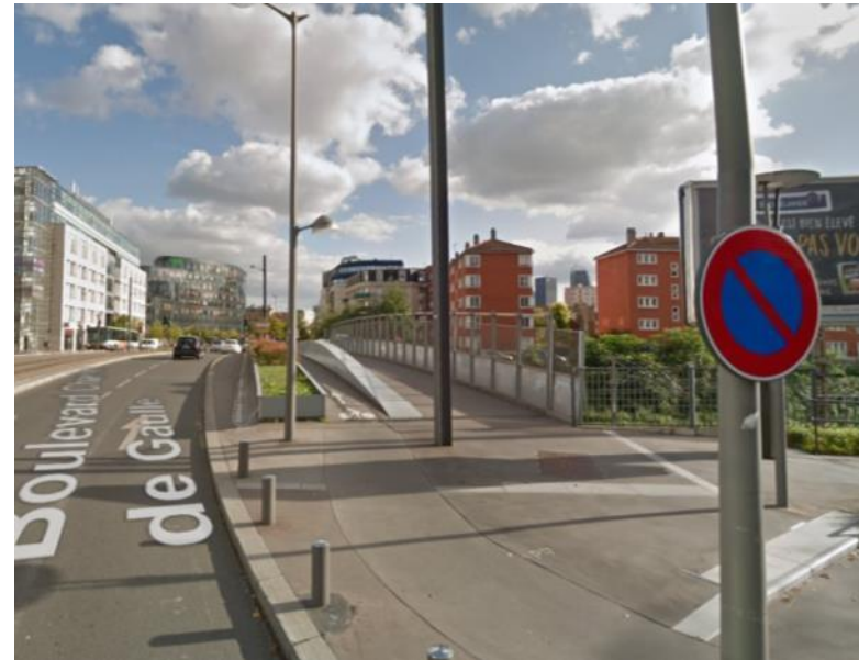
Pont de Charlebourg (Colombes)
