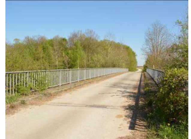
Passage supérieur routier
