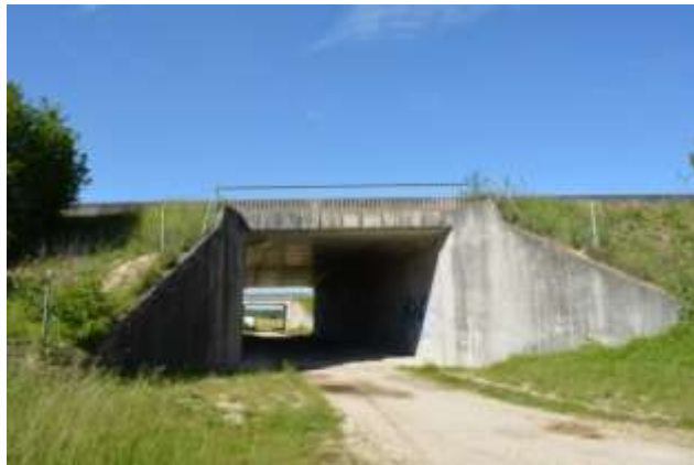
Passage inférieur agricole
