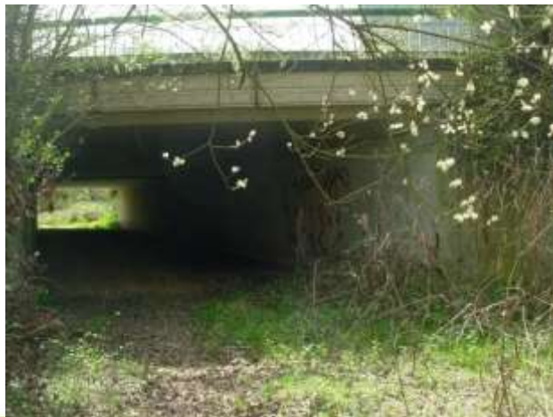
Passage inférieur traversé par un chemin agricole, Baillet-en-France (95)
