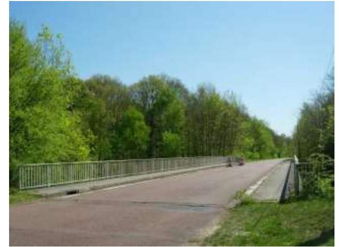
Passage couplé à une route
