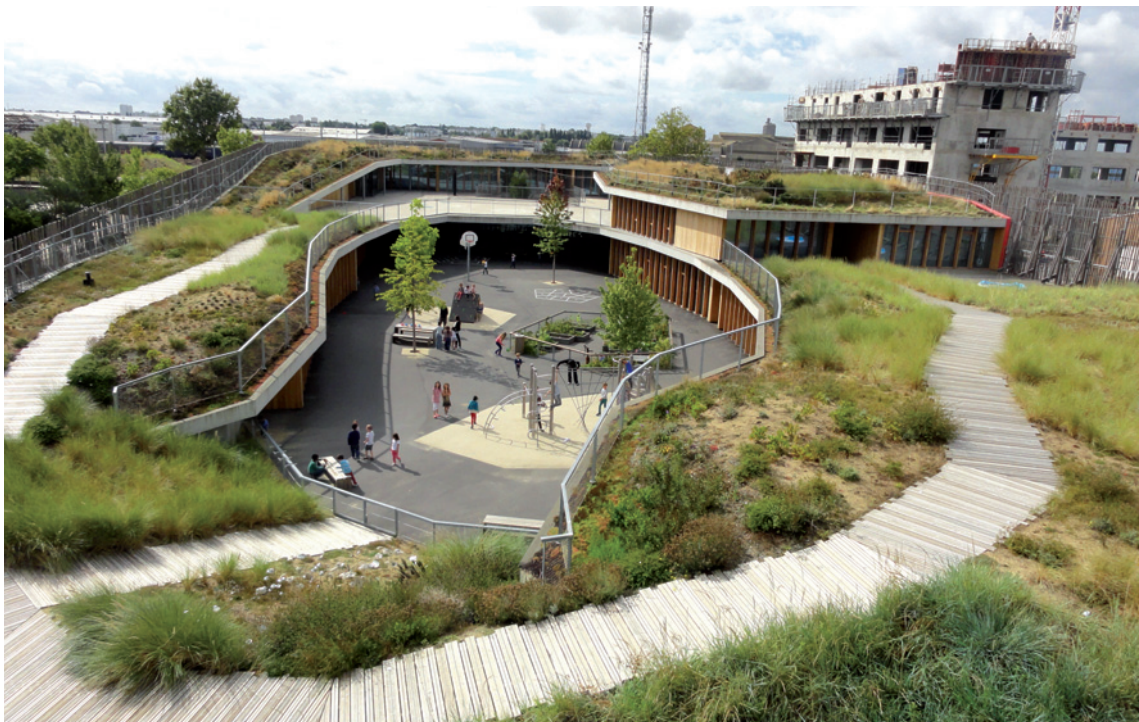
Toiture du Groupe scolaire Aimé Césaire.
