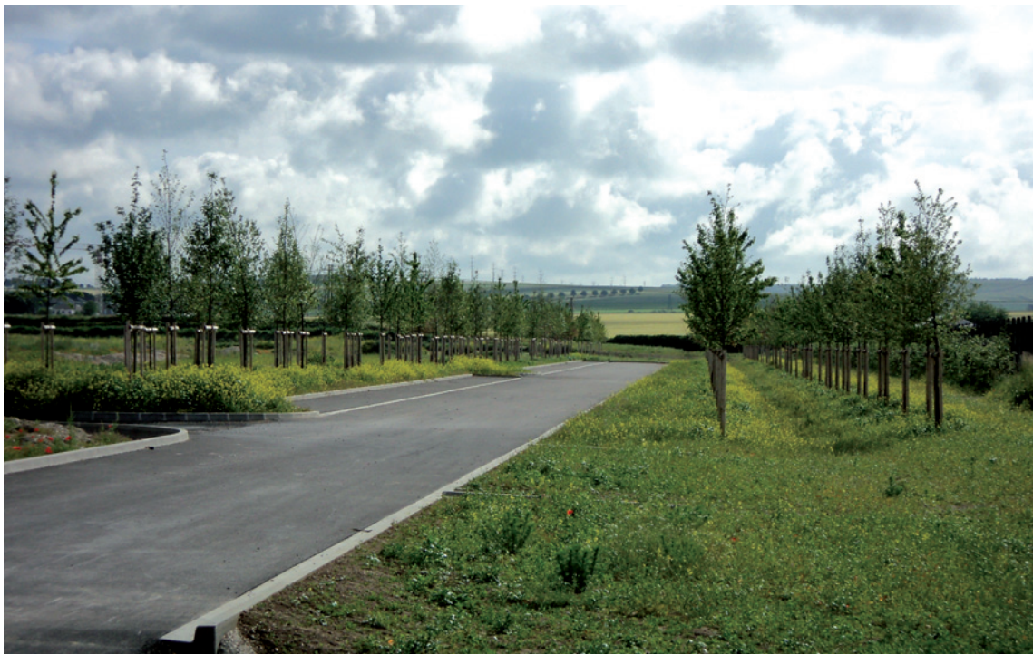
Travaux réalisés en juin 2013.
