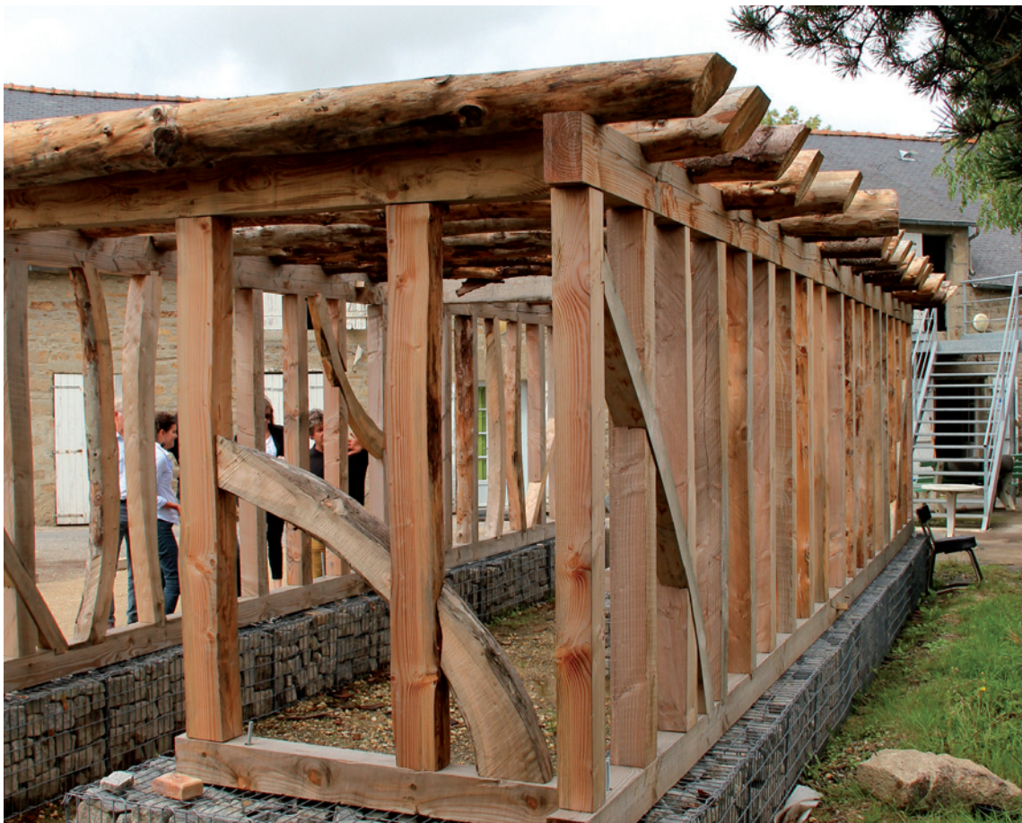
Abri à vélo en cours de construction avec du bois communal.
