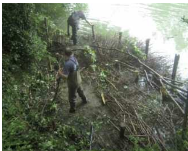
Le peigne, un ouvrage vivant
