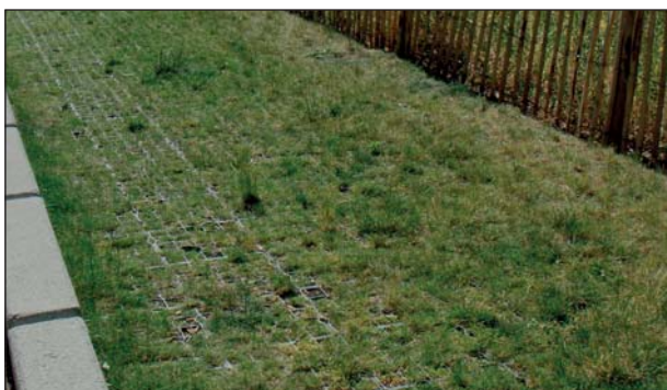
Bordure végétalisée longeant l'avenue du Château-du-Loir de Courbevoie.
