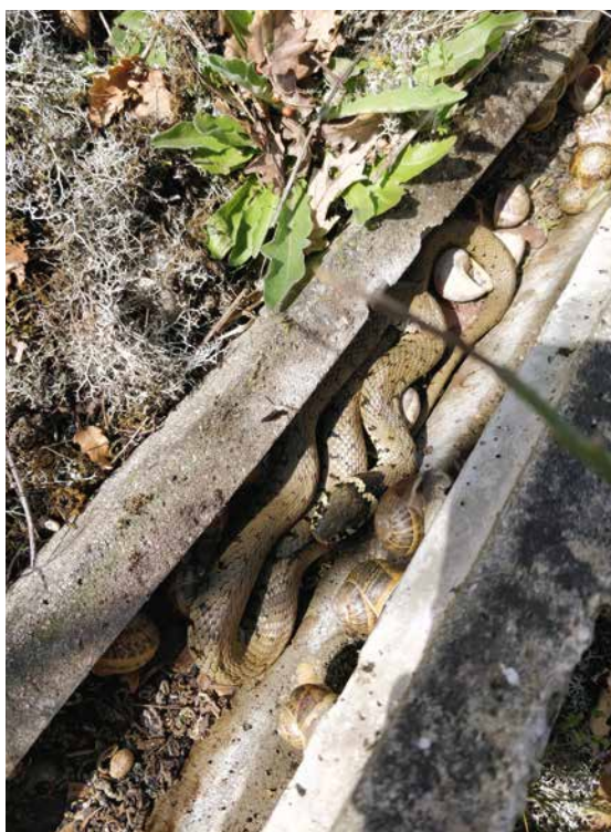
Les caniveaux à câbles qui longent les voies ferrées sont recouverts de dalles en béton (retirées ici) qui constituent des abris favorables aux reptiles. © Hemminki Johan
