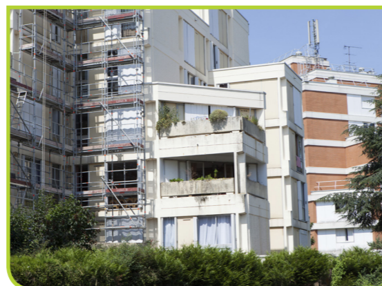
Rénovation énergétique dans une copropriété de Trappes
