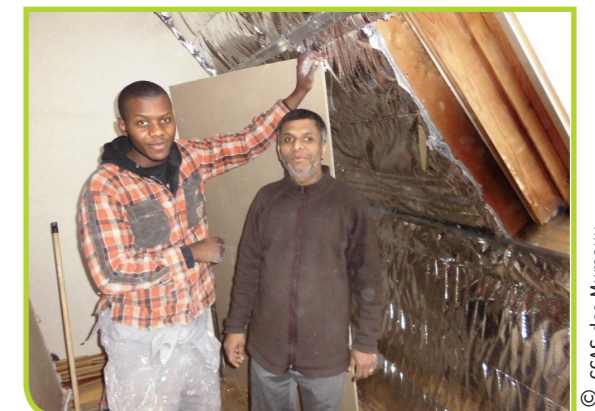
Isolation de combles en auto-réhabilitation accompagnée
