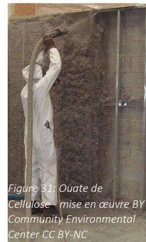
Figure 31: Ouate de Cellulose - mise en œuvre BY Community Environmental Center CC BY-NC
