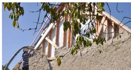
Figure 24 : Projection de béton de chanvre - Courtesy AKTA
