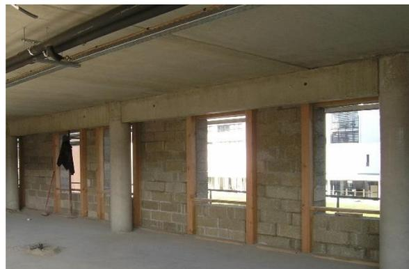
Figure 23 : Bloc bétons de chanvre - Maison de l'Habitat Clermont Ferrand / Courtesy © A Duverger
