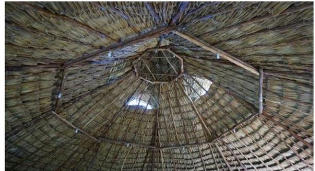
Figure 21 : Toiture en palme Yucatan - Courtesy © M Boyeux et L Lénée-Corrèze (2)
