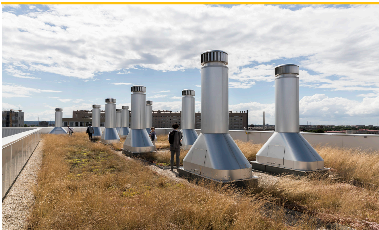
Les cheminées d'extraction
