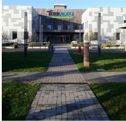
Un grand bâtiment rénové en 2007
