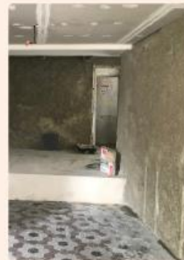
LE TIERS-LAB DES TRANSITIONS Isolation intérieure chaux chanvre
