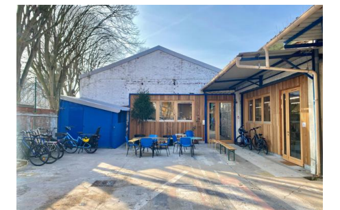
ILE-SAINT-DENIS LA BALISE Activités ESS
