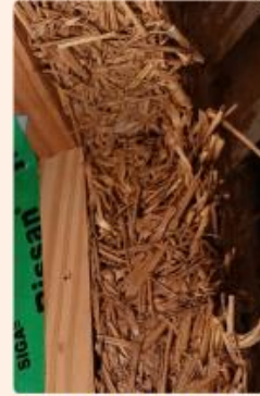
LE TIERS-LAB DES TRANSITIONS Isolation intérieure paille
