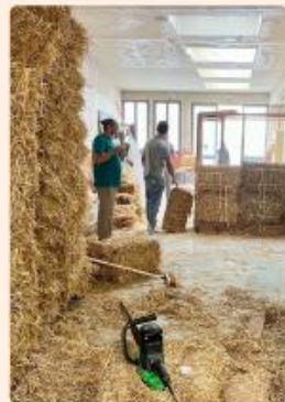
PRUDHON Isolation Thermique Extérieure ITE paille
