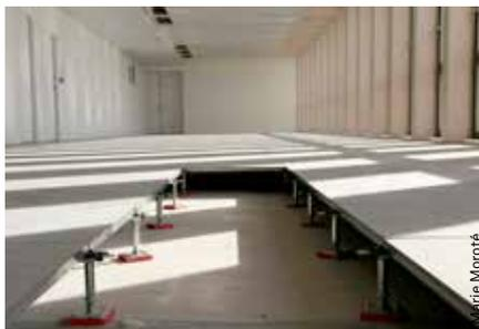
Mise en œuvre du faux plancher issu du réemploi.
