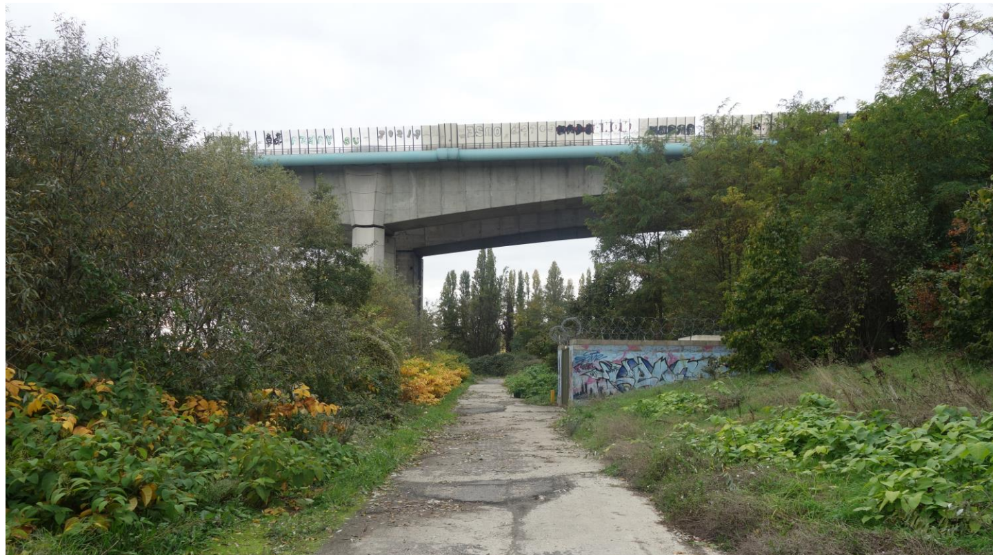
Viaduc de l'A15, photographie : Louis Comte
