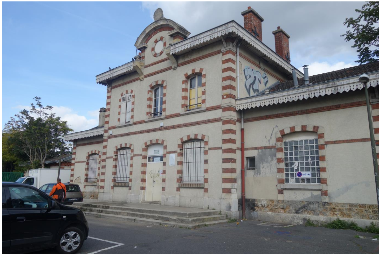
Gare d'Argenteuil grande Ceinture, désaffectée depuis 1939, prévue pour être remise ne service pour le T11 express vers 2027, photographie : Louis Comte
