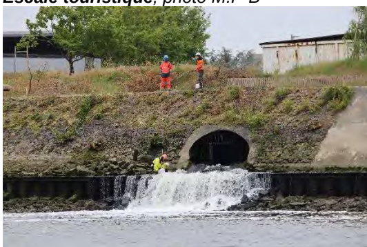
Ouvrage traversant , photo M.P-B
