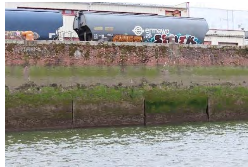
Berge homogène de la zone intertidale au haut de berge : perré maçonné vertical, photo M.P-B
