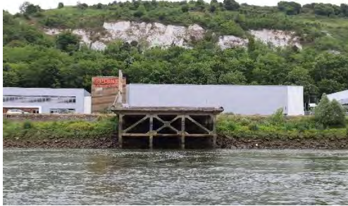
Changement ponctuel de type de berge : estacade béton, photo M.P-B
