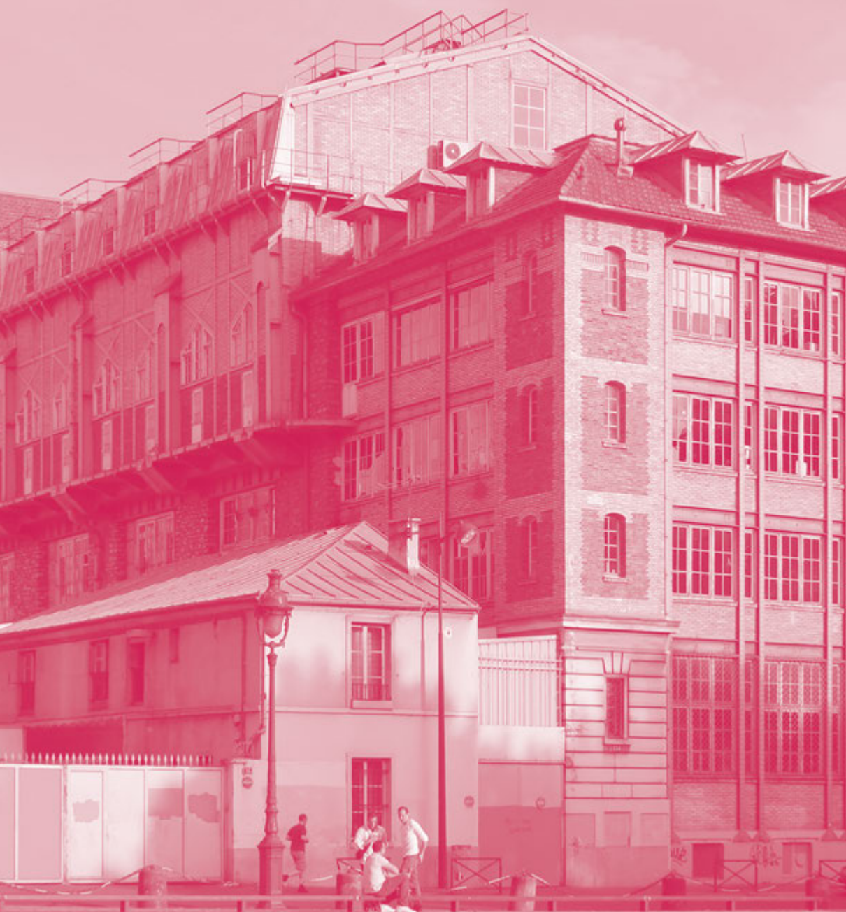
Ancienne usine électrique à Paris reconvertie en production de papeterie © Coyau / Wikimedia Commons / CC BY-SA 3.0 PJI-Elle Wikipédia
