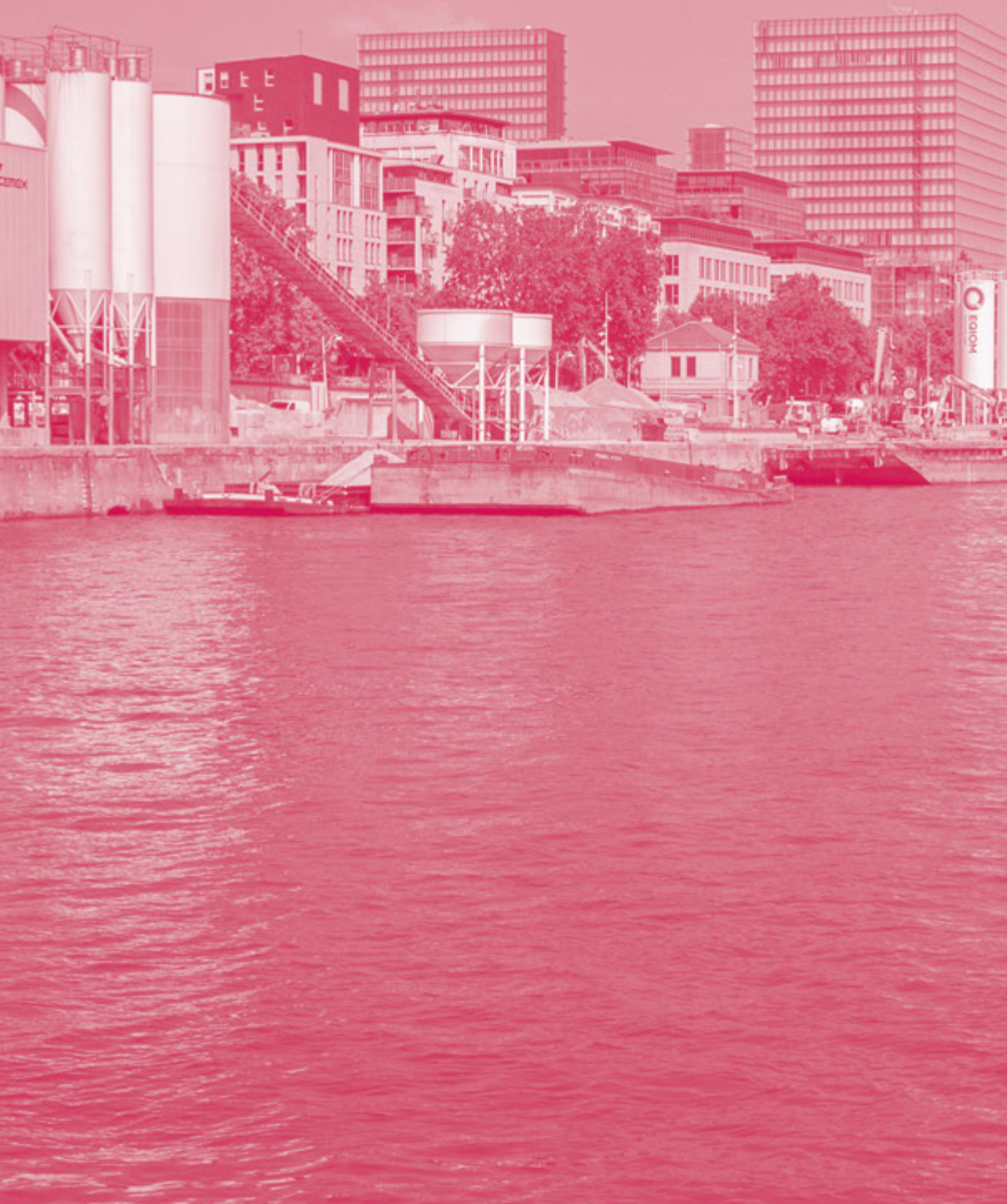
Cimenterie Cemex implantée en bordure de Seine, quai d'Ivry à Paris © Pierre-Yves Brunaud / L'Institut Paris Region
