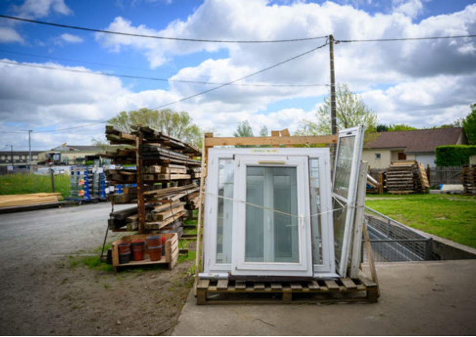
Fenêtres stockées dans les locaux d'Accro'Bat, association environnementale de collecte et de réemploi des matériaux de chantier © Arnaud Bouissou / Terra
