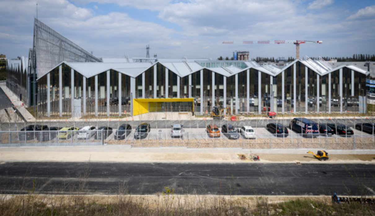
Ligne de tramway T9 - Site de maintenance et de remisage © Arnaud Bouissou / Terra
