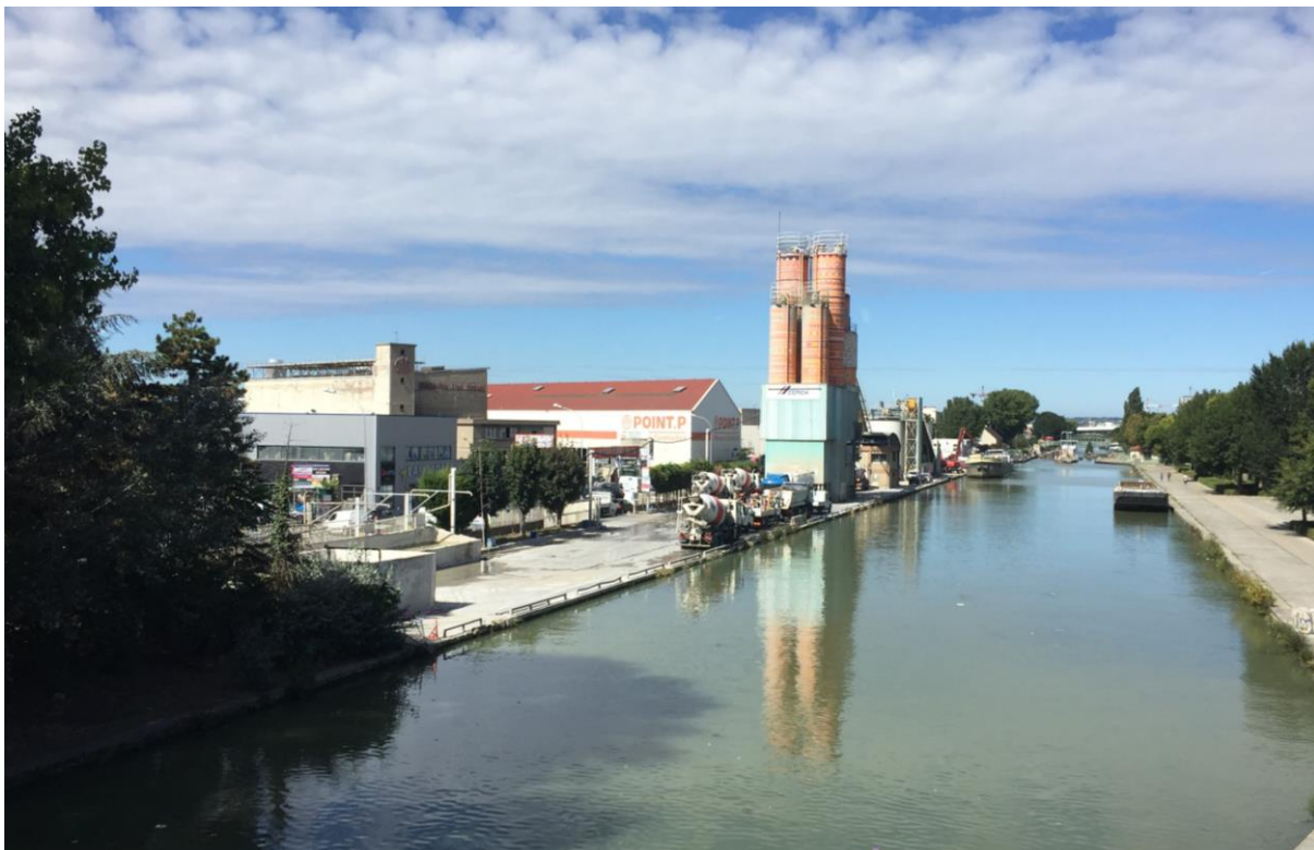
Vue sur une centrale à béton à Aubervilliers. Martial Vialleix/L'Institut Paris Region, 2020.
