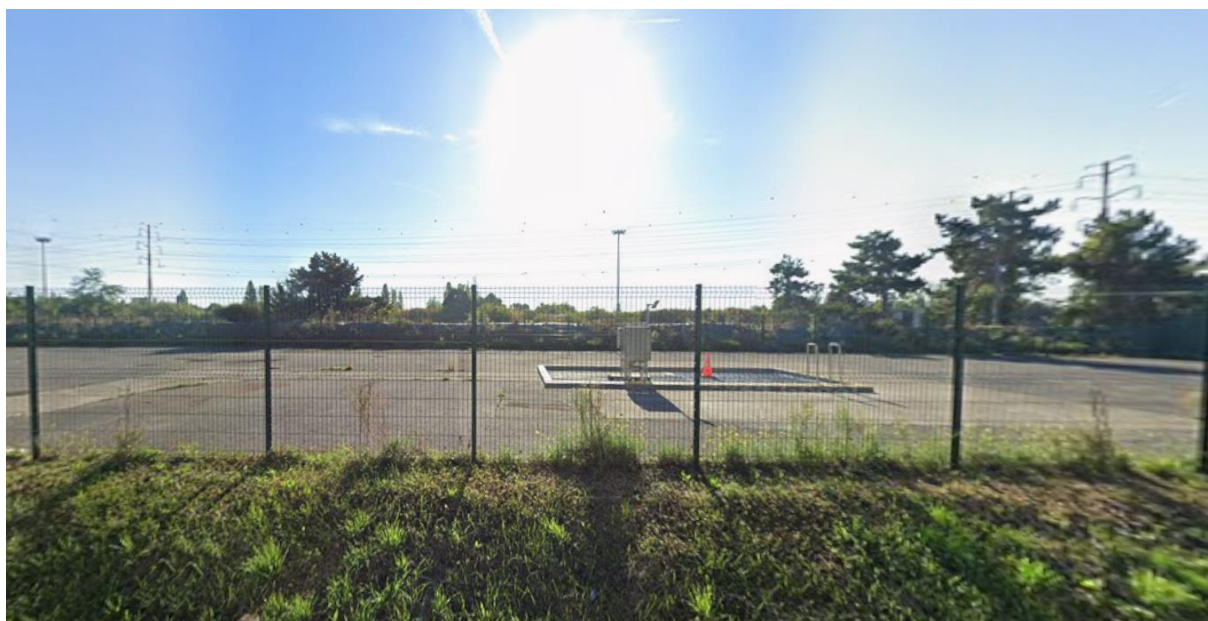
Exemple d'espace mobilisé pour des ouvrages de géothermie à Fresnes (94). Source : Google Street View, année 2022, capture d'écran réalisée en avril 2024.
