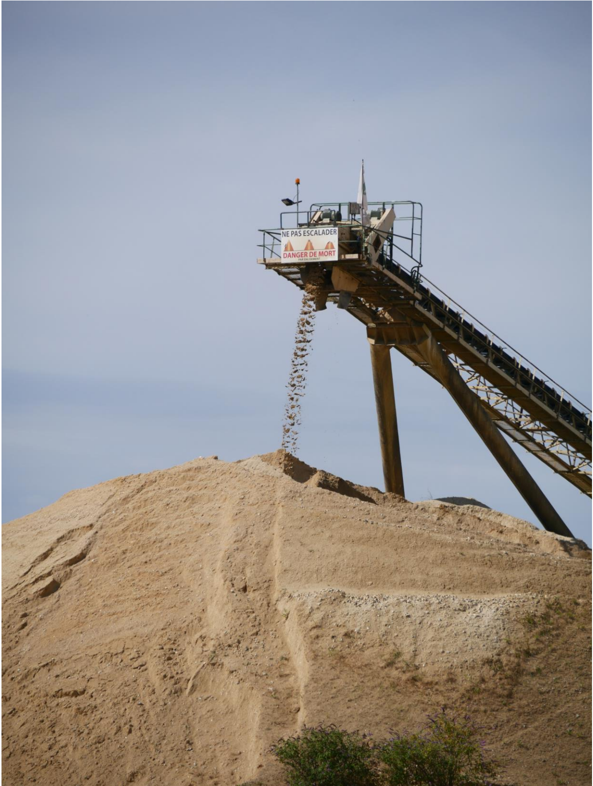
Installation de traitement des granulats à Sandrancourt. Jean Bénét/L'Institut Paris Region, 2024
