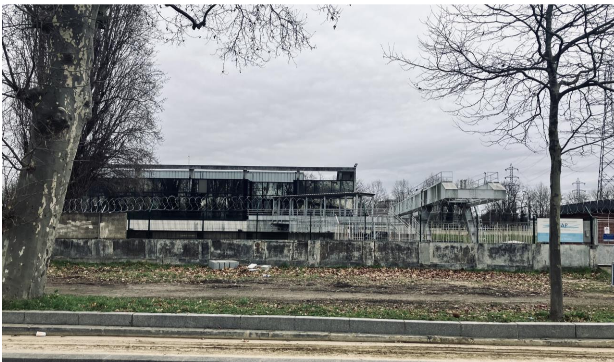
Station d'épuration d'Épinay-sur-Seine (93). Martial Vialleix/L'Institut Paris Region, 2025
