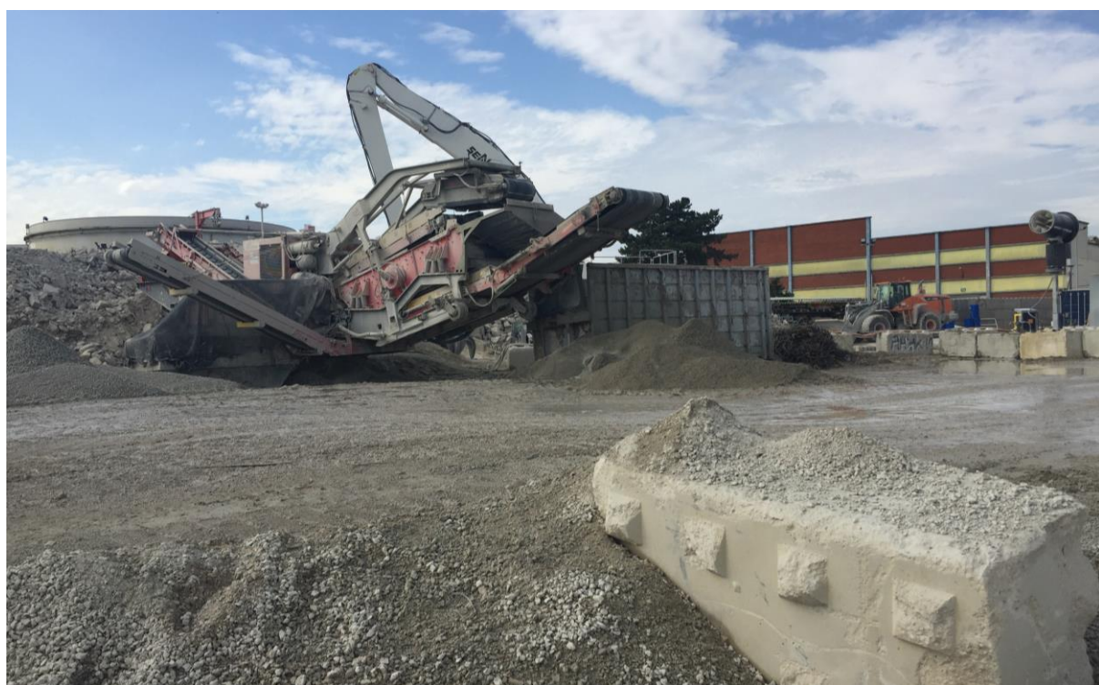
Concassage de matériaux sur la plateforme de recyclage de Cemex à Gennevilliers. Martial Vialleix/L'Institut Paris Region, 2022
