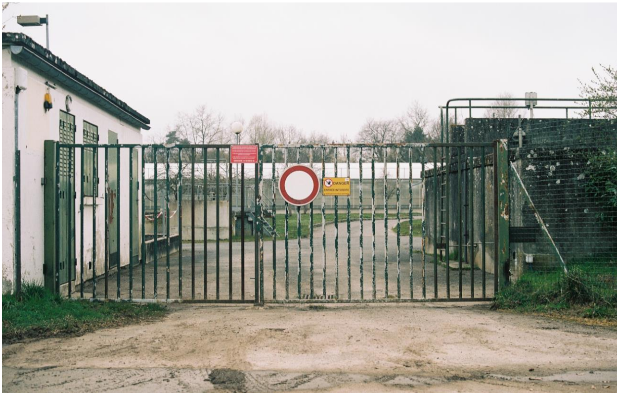
Station d'épuration de Bourron-Marlotte (77). Martial Vialleix/L'Institut Paris Region, 2021.
