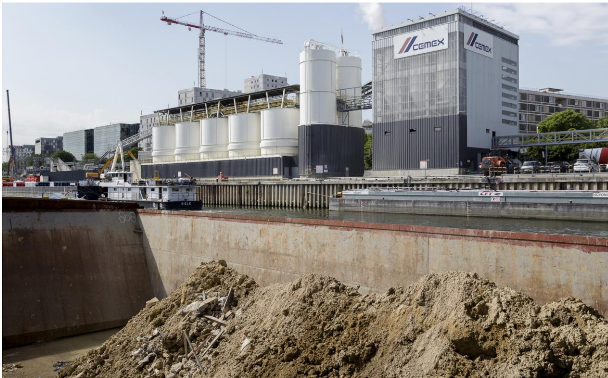
Centrale à béton et péniche avec matériaux à Paris. Pierre-Yves Brunaud/L'Institut Paris Region.
