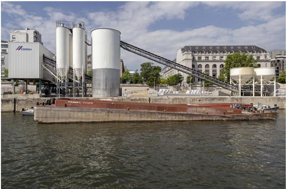
Centrale à béton à Paris. Pierre-Yves Brunaud/L'Institut Paris Region.
