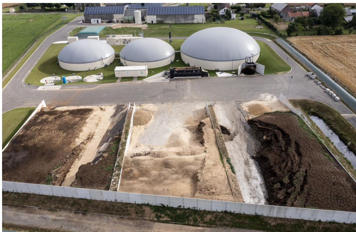
Usine de méthanisation à Ormoy-la-Rivière. Éric Garault/L'Institut Paris Region
