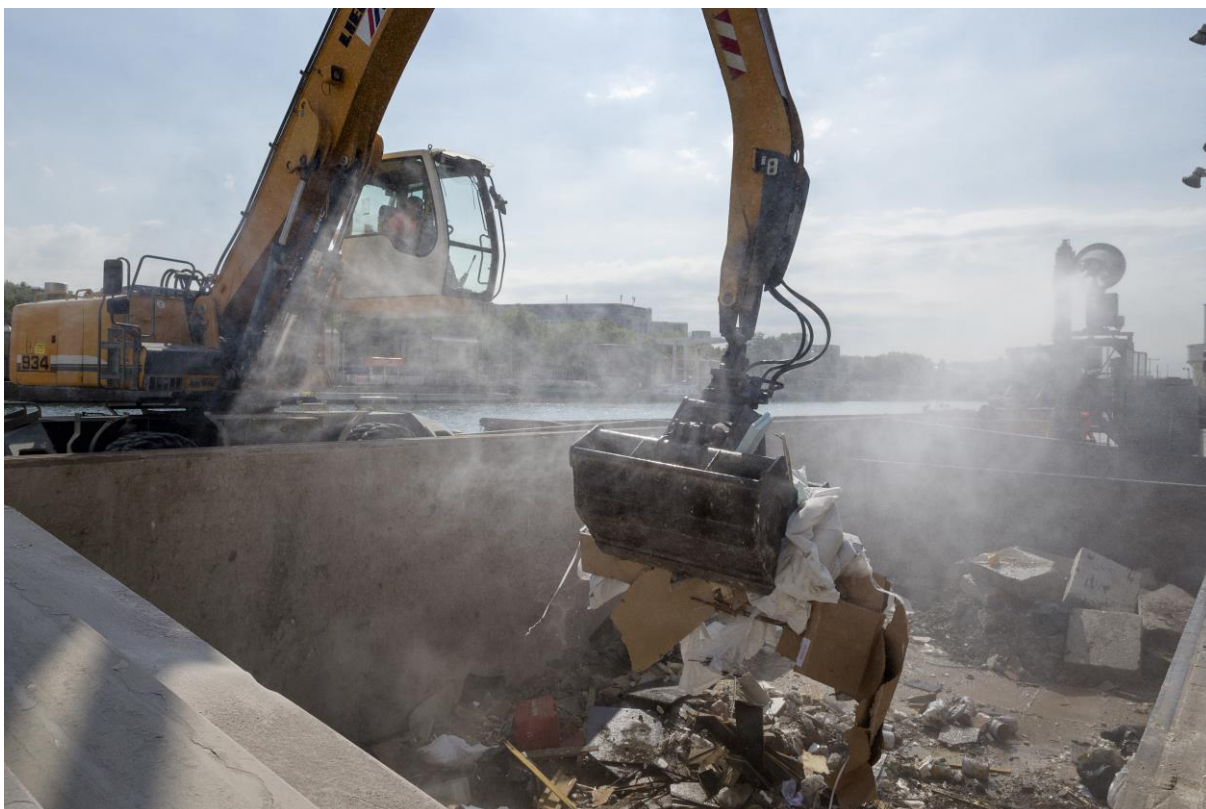
Opérations de chargement et de déchargement de matériaux sur une plateforme parisienne. Pierre-Yves Brunaud/L'Institut Paris Region
