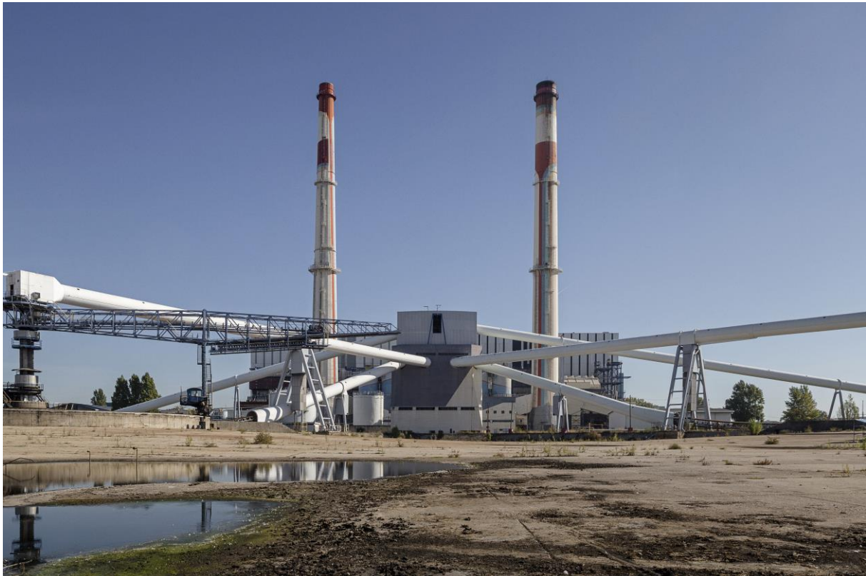
Les Ardoines, site de la centrale thermique de Vitry-sur-Seine, en cours de démantèlement. Pierre-Yves Brunaud/L'Institut Paris Region.
