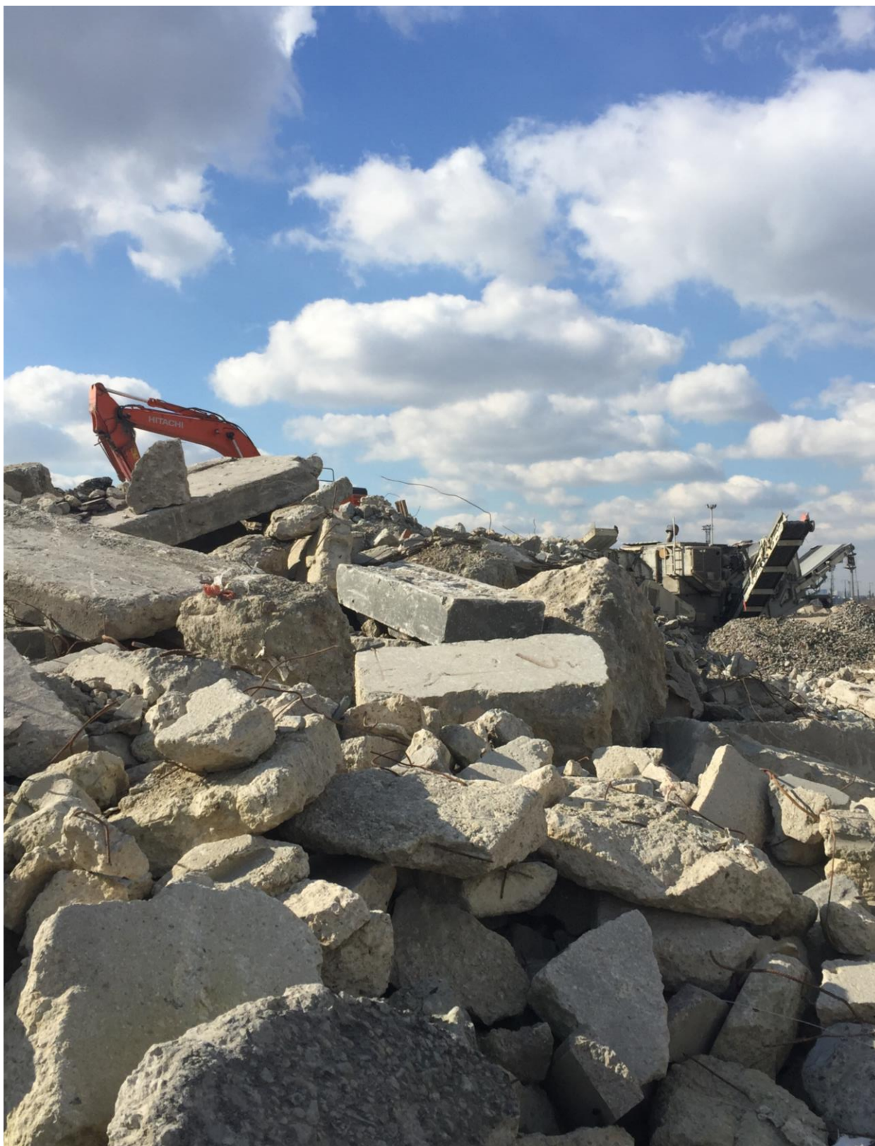
Plateforme de traitement des matériaux inertes à Bobigny. Martial Vialleix/L'Institut Paris Region, 2023.
