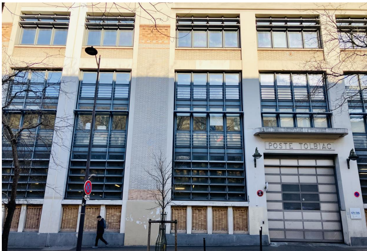
Poste de transformation électrique à Paris. Martial Vialleix/L'Institut Paris Region, 2024.
