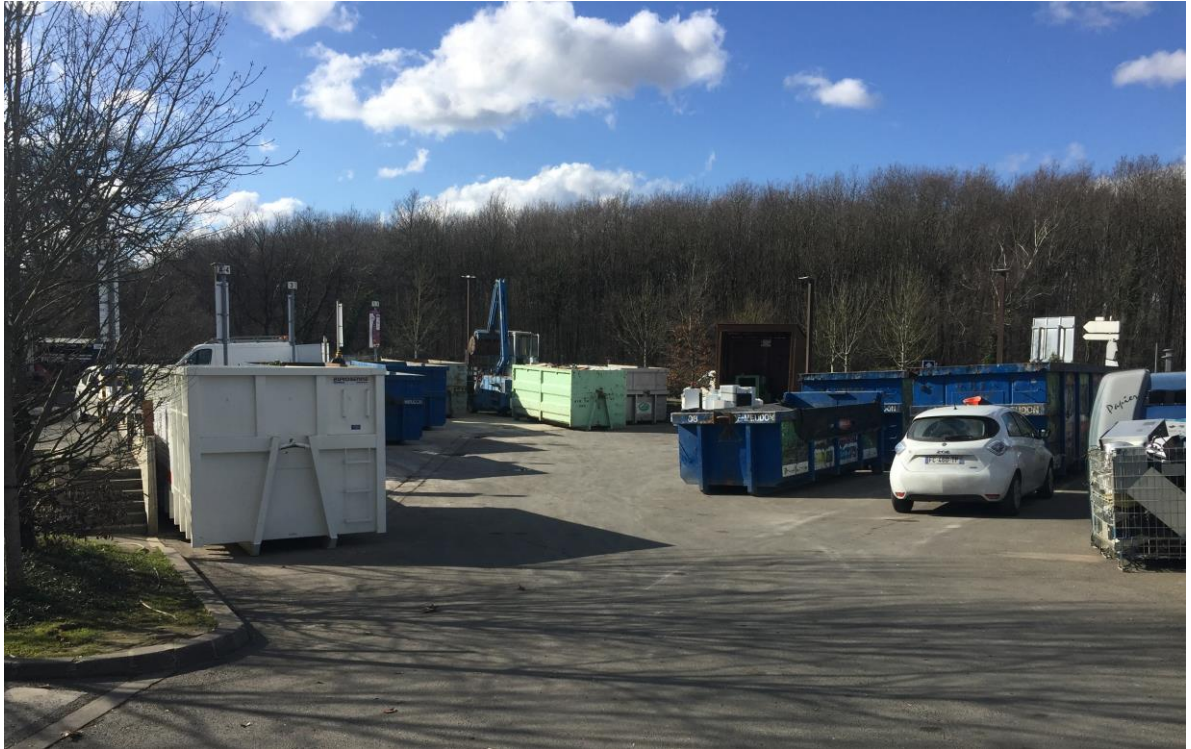
Déchetterie de Meudon. Martial Vialleix/L'Institut Paris Region, 2023.
