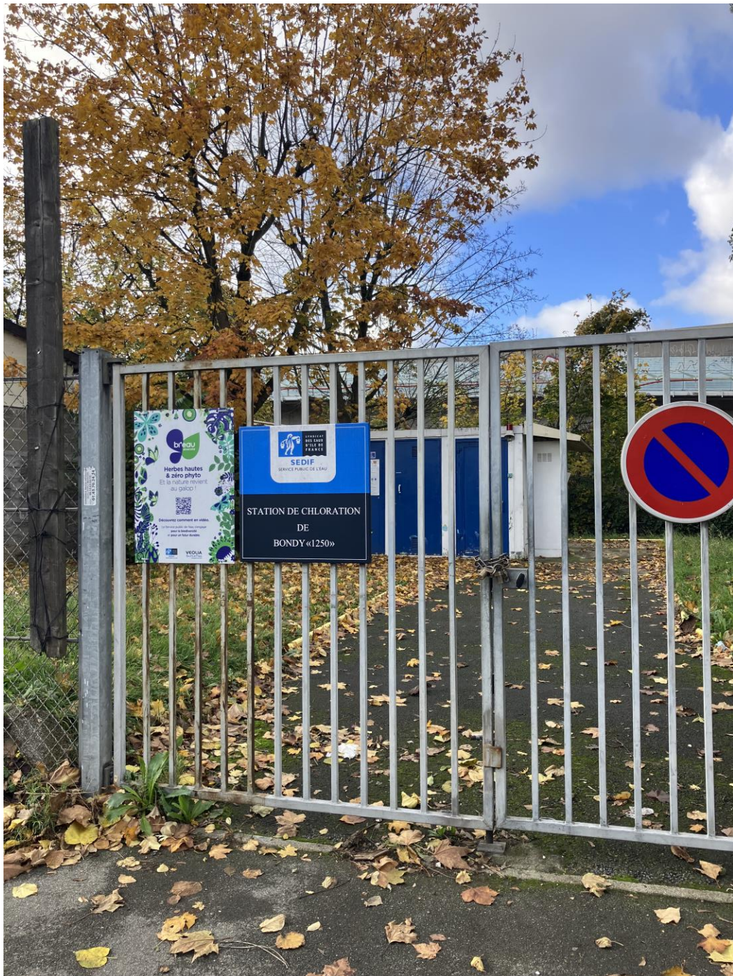
Station de chloration du SEDIF à Bondy. Martial Vialleix/L'Institut Paris Region, 2023.
