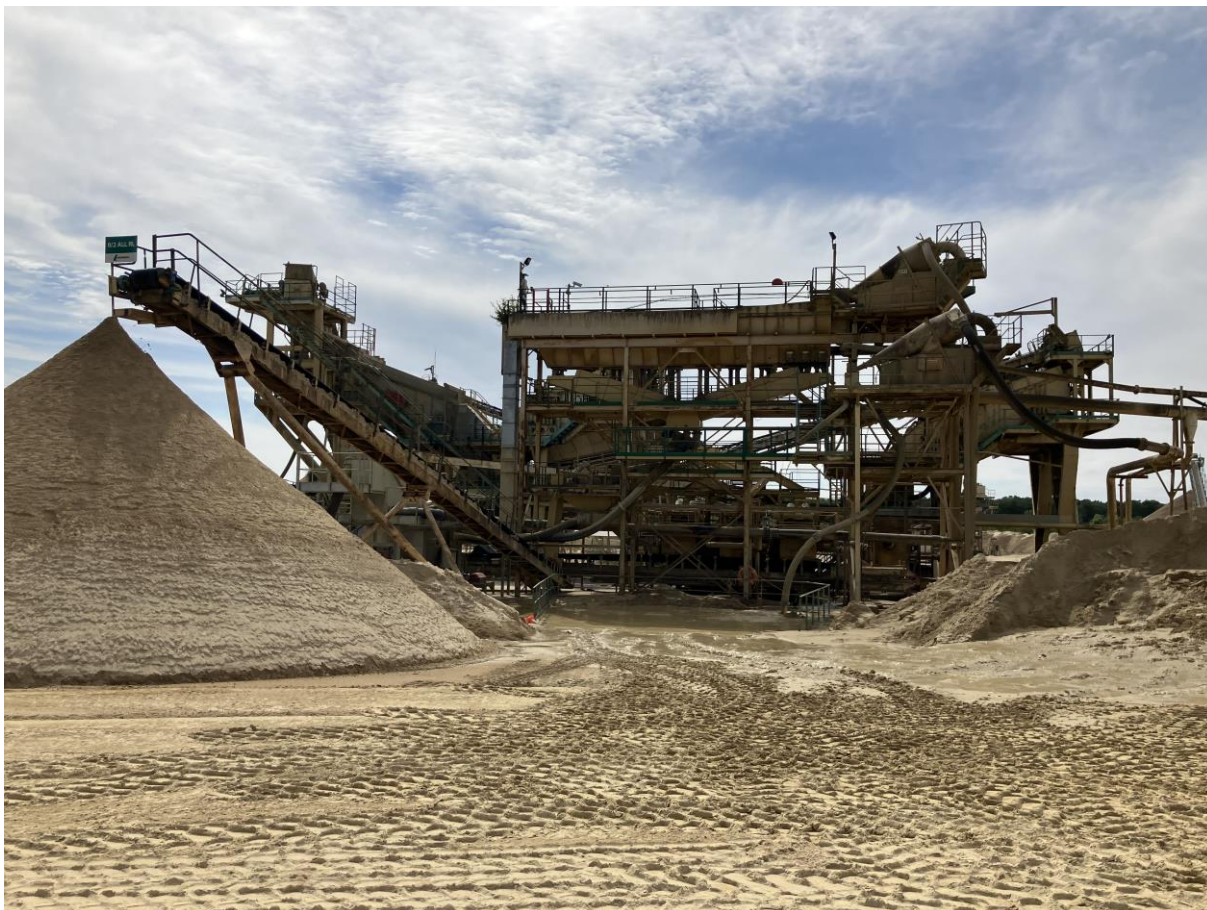
Installation de traitement des granulats à Sandrancourt. Martial Vialleix/L'Institut Paris Region, 2024
