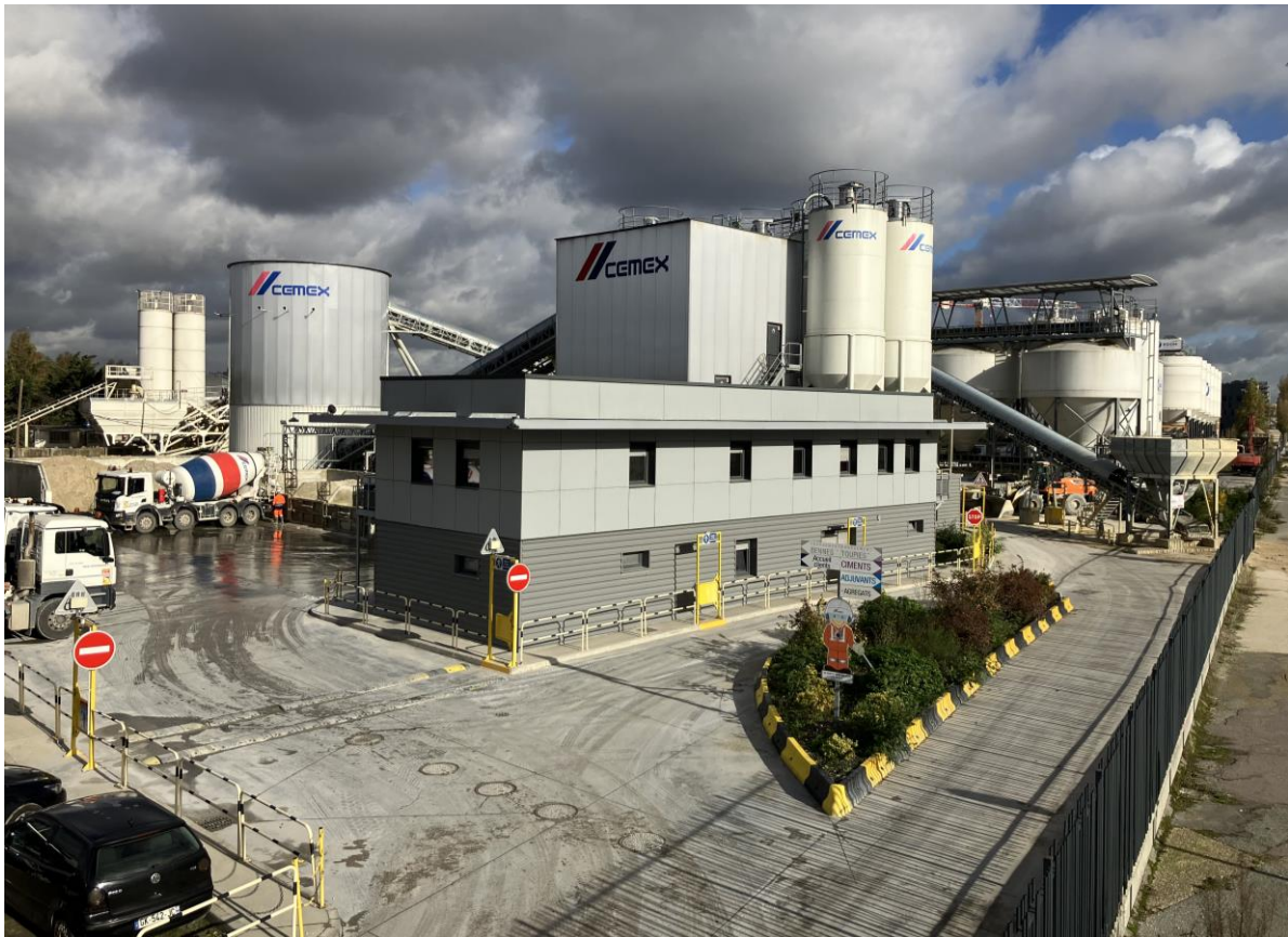
Centrale à béton à Bondy. Martial Vialleix/L'Institut Paris Region, 2023.
