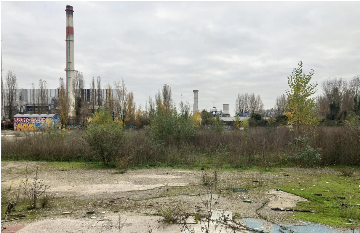
Centrales thermiques à Vitry-sur-Seine. Martial Vialleix/L'Institut Paris Region, 2024
