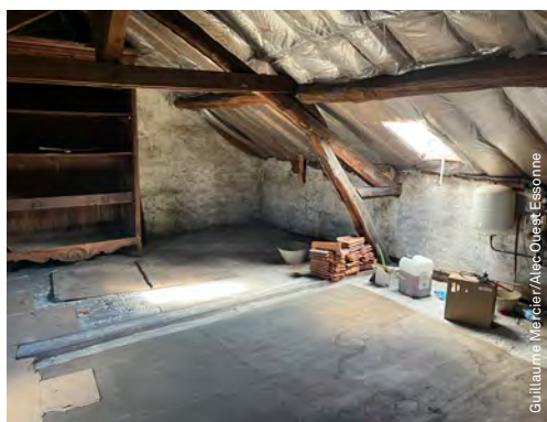
Chantier d'auto-rénovation à Montlhéry accompagné par l'Alec Ouest Essonne
