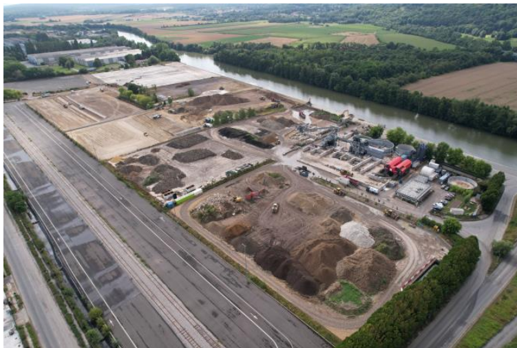
Illustration 9. Vue aérienne de la plateforme Vinci Extract de Bruyères-sur-Oise (Source Vinci Extract)
