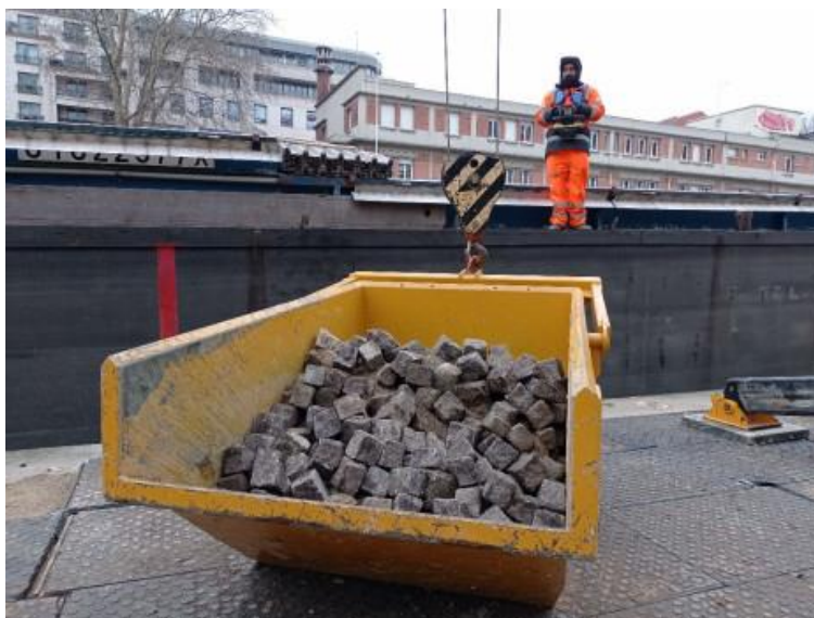
Illustration 6. Grutage d'un chargement de pavés Quai de Jemmapes (Source BatiActu – janvier 2025)
