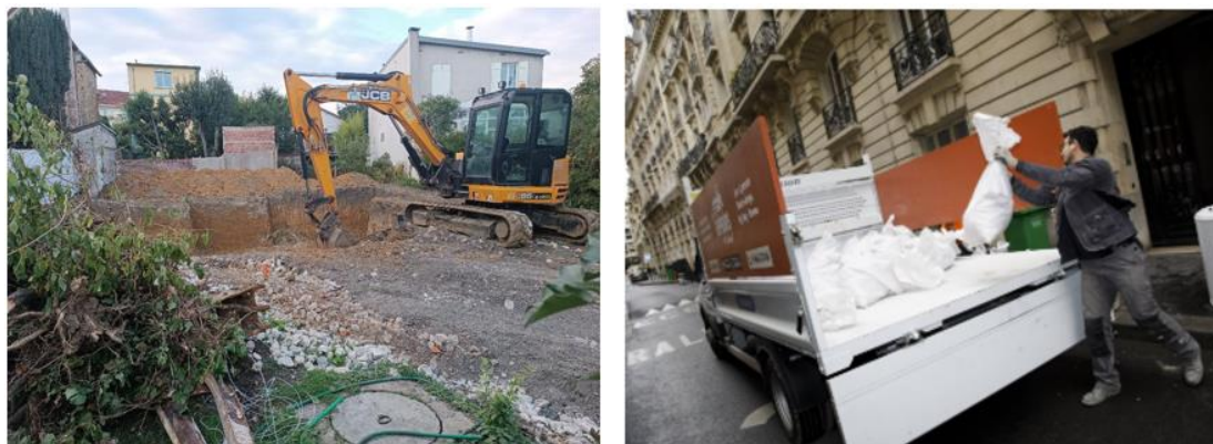
Illustration 7 et 8. Un petit chantier urbain à Fontenay-aux Roses (Source Beyer - 2025)/ Le service mutualisé de collecte de déchets de petits chantiers urbains (Source Les Ripeurs)
