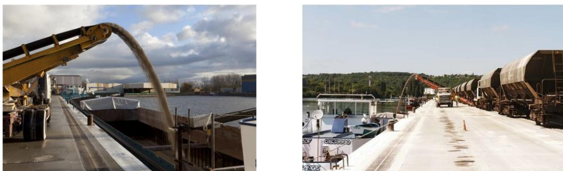
Illustrations 15. Opérations de transfert des granulats entre le rail et la voie d'eau à Limay (source Carrières du Boulonnais et Moniteur des Travaux Publics)
