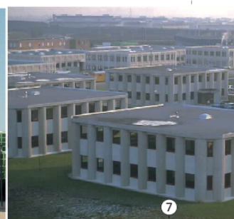
Structure béton, façades béton préfabriqué
