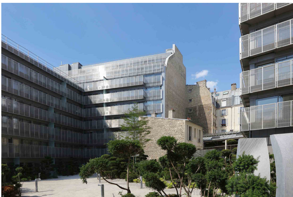
Le bâtiment réhabilité avant et après travaux vu depuis les bâtiments rue Campagne-Première. FSA et Jean Pierre Porcher/FSA
