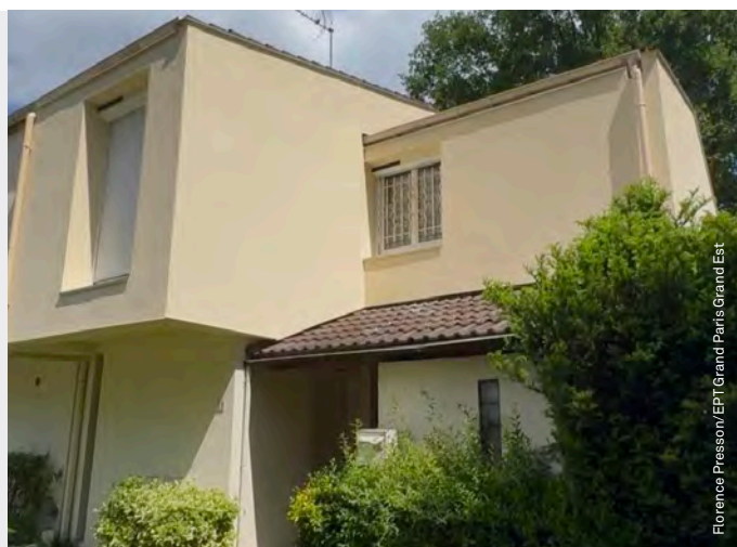
Pavillon rénové à Noisy-le-Grand (93)
