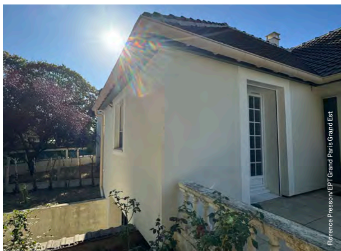
Pavillon rénové à Noisy-le-Grand (93)
