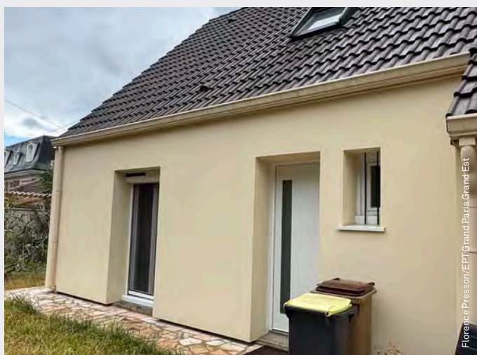
Pavillon rénové à Neuilly-sur-Marne (93)
