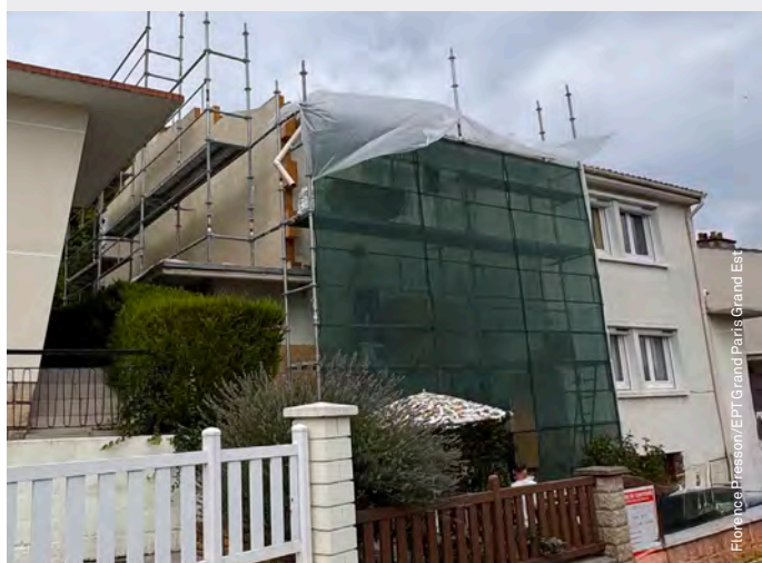
Rénovation d'un pavillon à Gagny (93) dans un lotissement accompagné par l'EPT Grand Paris Grand Est
